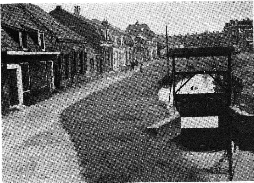
4. Schut in het Zwarte Water op de hoek van Snelliuskade en Nieuwe Koekoekstraat.
