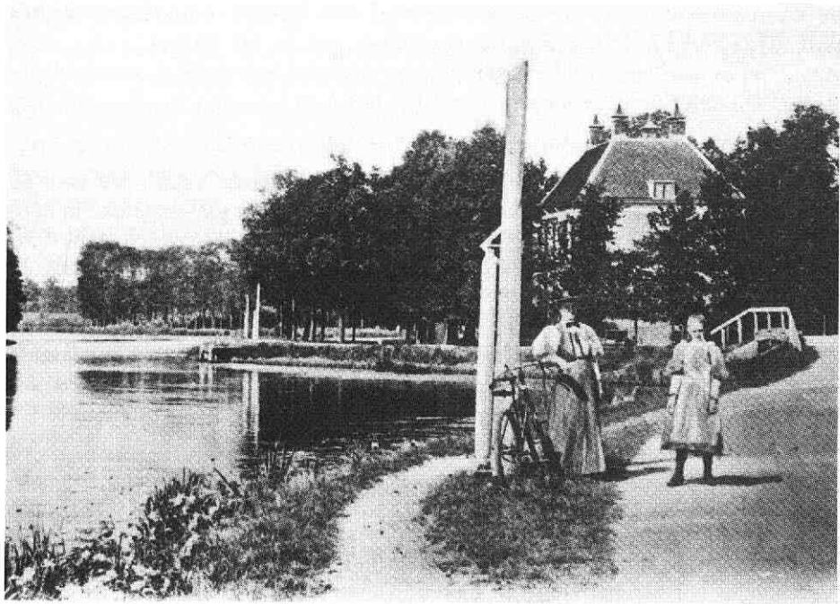
Rolpalen nabij Weerestein, ten behoeve van het geleiden van de jaaglijn.
