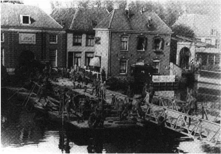
Afb. 6. Brugslag oefeningen door het eerste Regiment Genietroepen uit Utrecht, 1931 (Historische Genie Verzameling Vught).
