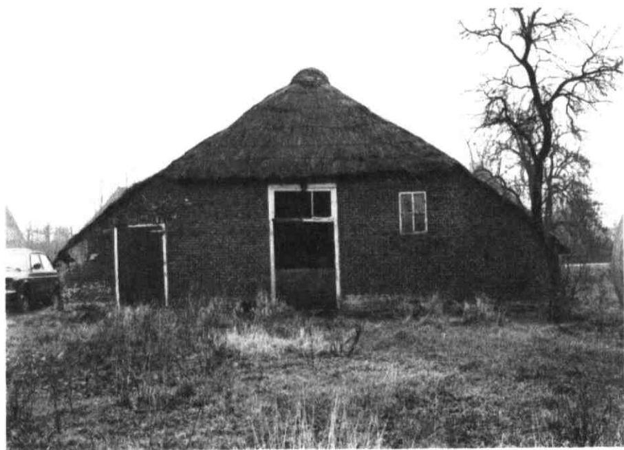
Afb.4 Achtergevel van de boerderij Waalseweg 53 te Tull en 't Waal. Goed te zien zijn de vlechtingen waarmee de schuine zijden aan deze gevel zijn beëindigd. In het midden de smalle deeldeur, bestaande uit een onder- en bovendeur. De kleine deur geeft toegang tot de linkerkzijbeuk, waarin de stal was ondergebracht. Foto SHBO.
