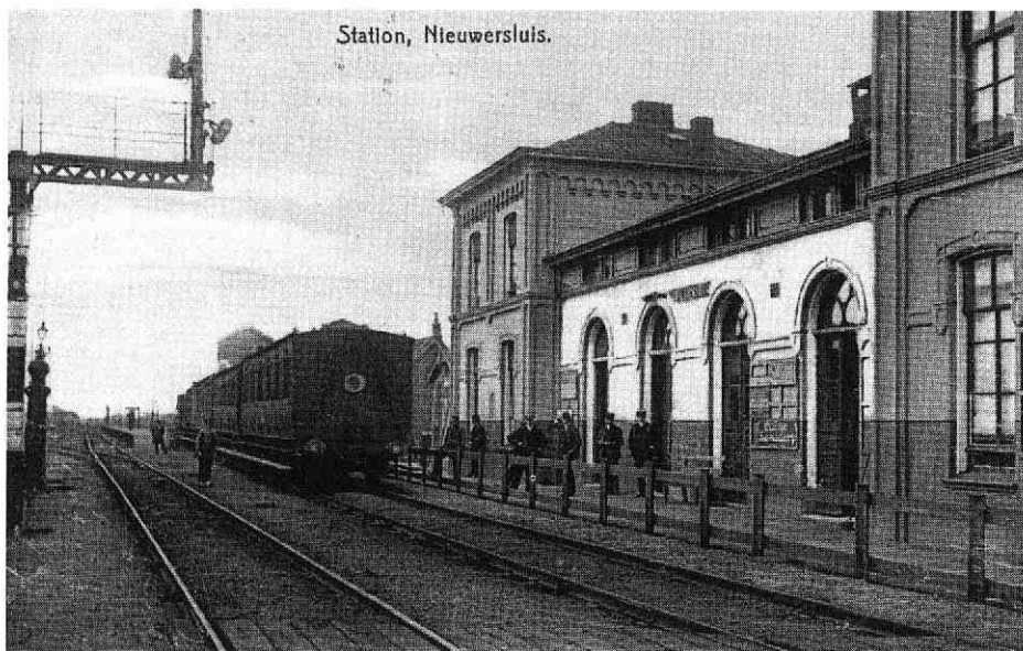
Afb. 1. Station Nieuwersluis in 1904 met een trein richting Utrecht. Links naast de seininstallatie is een waterafgiftekolom te zien. (Coll. Lisman)
