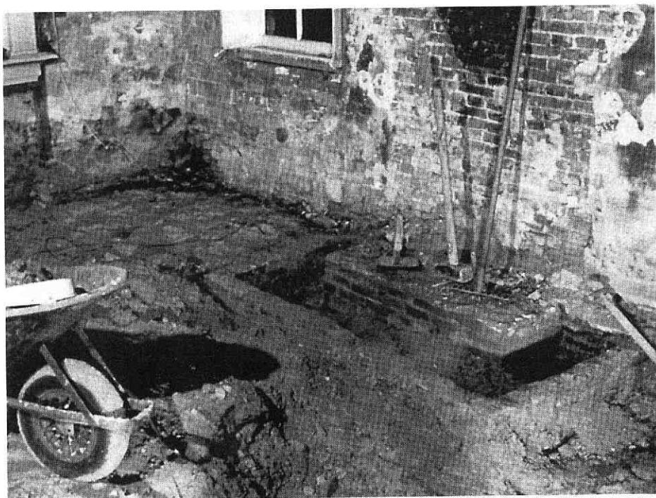
Afbeelding 2. De schouwfunderingen in de oude keuken. De kleine binnenste fundering behoort bij de schouw, die aangebracht werd tijdens de verbouwing van 1964. Foto L. Vonk, februari 1999.
