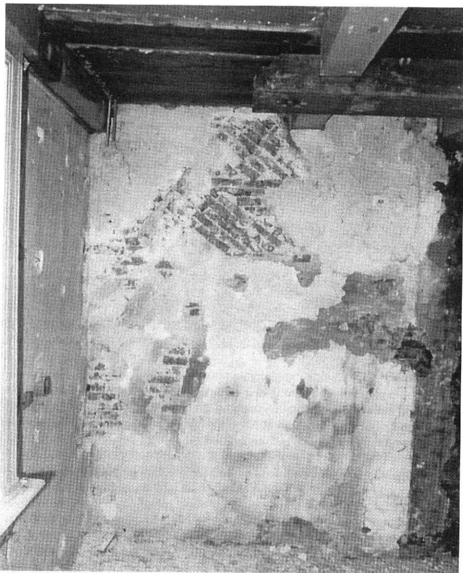
Afbeelding 5. Bouwspoor 53. Het vlechtwerk van de topgevel is duidelijk herkenbaar.
