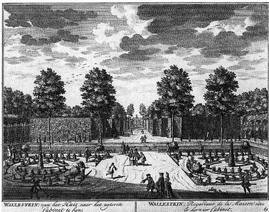
Afb. 3. Het uitzicht over de tuin vanuit het huis Wallesteyn over de brede achtergracht langs de zicht-as naar de portico met pilaren en beelden, die het sluitstuk van de zichtlaan vormde. Ook hier zijn de berceaux te zien (Prent 69, Coll. auteur)
