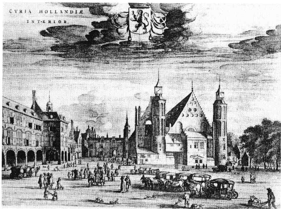
Afb. 8. Het Binnenhof te Den Haag in de 17 e eeuw; het gebouw links achteraan was de zetel van de Raad van Brabant. (C.B.v.G. Jb. 2001)
