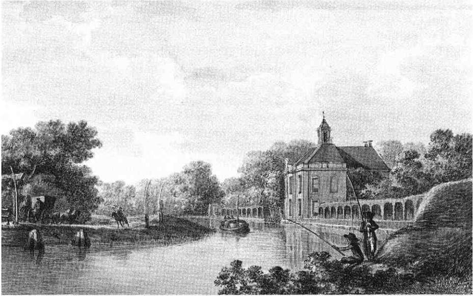
Afb. 4. Rupelmonde vanaf fort Nieuwersluis, naar het zuiden gezien. Rechts is een deel van de aarden wal om het fort te zien. De berceaux aan weerszijden van het huis duiden op een traditioneel-geometrische parkaanleg, doch de hogere bomen daarachter doen vermoeden dat die plaats ging maken voor de Engelse mode. Met waterverf ingekleurde gravure door H. Numan, 1793. (Coll. auteur)
