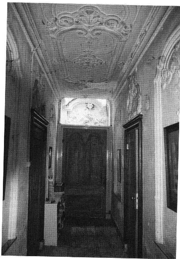
Afb. 7. Stucwerk in de zijgang met de originele 18e-eeuwse eiken deuren. (Foto Schoorl)
