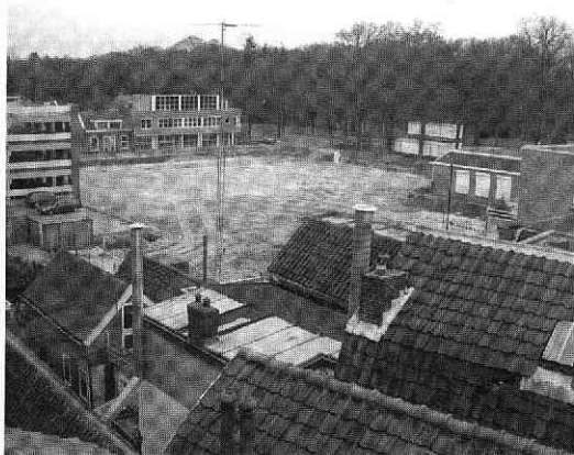
Het braakliggende terrein op de hoek Jufferstraat / Laan van Beek & Royen. Wordt de stalhouderij. Links de parkeergarage Figi.
