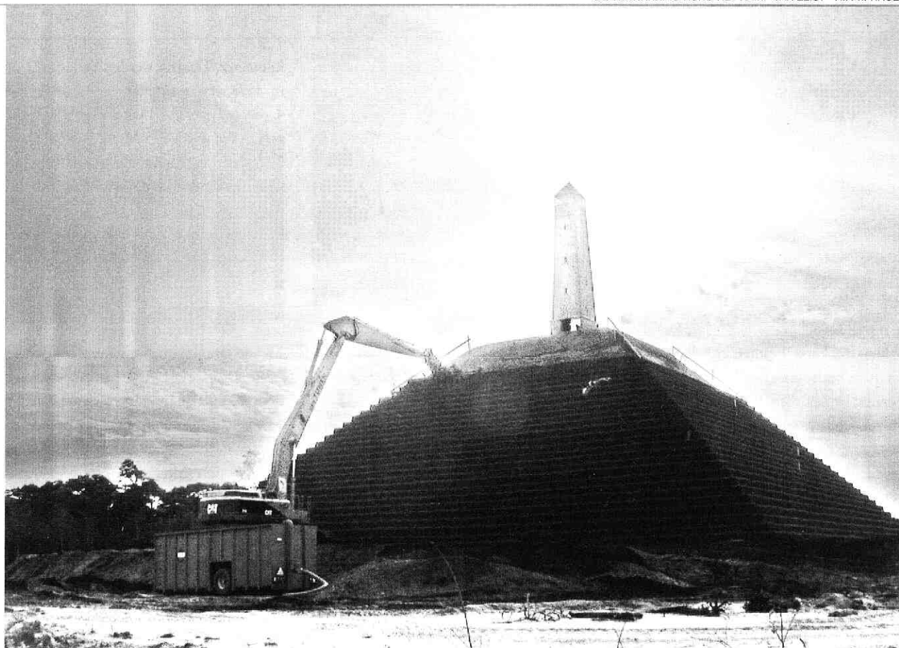
Herstelwerkzaamheden aan de piramide (oktober 2003).
