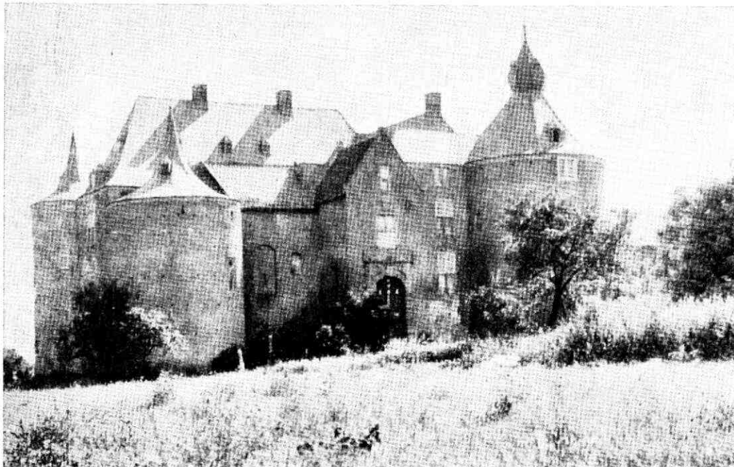
Voorgevel van kasteel Ammersoyen, vóór de restauratie
