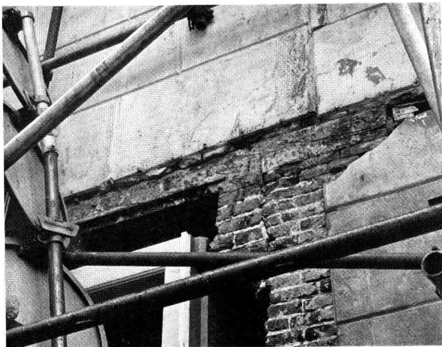
Kozijndetail en balklaag
