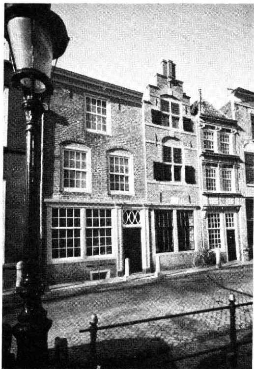
Foto 1. Nieuwegracht 39 na de restauratie.
