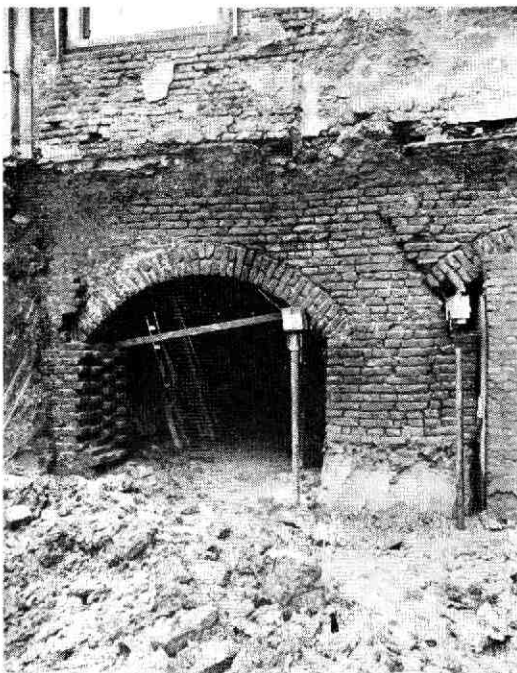
Afb. 1. De muur links van de boog eindigt in een zgn. staande tand.
