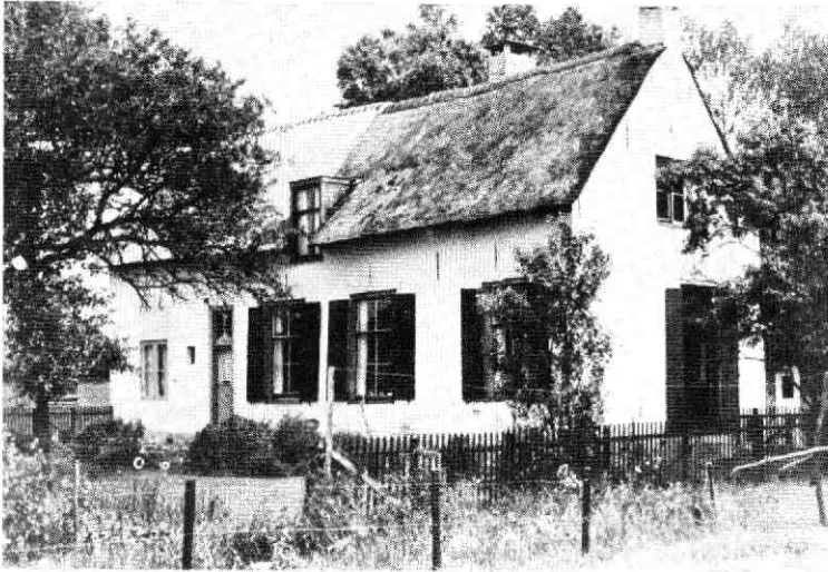
Eenvoudige boerderij van goede verhoudingen, met voor en achter een topgevel, waartussen opgesloten een met riet gedekt zadeldak. Goed geplaatste schoorstenen.
