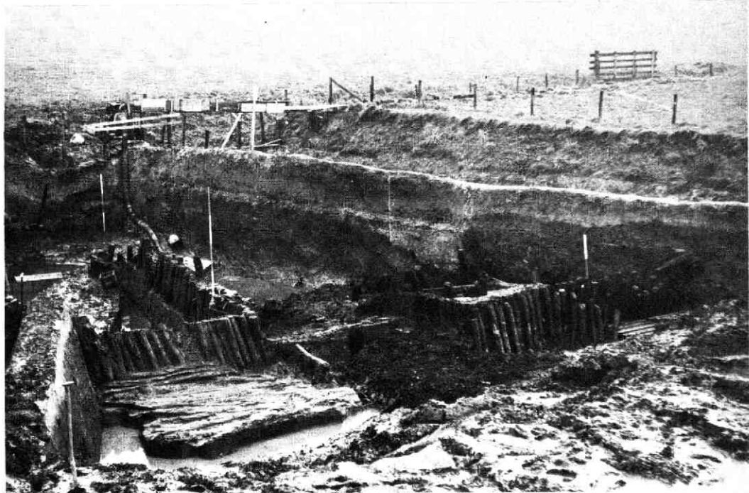
Afb. 7. Bunnik - Vechten: houtwerk in ROM Rijnbedding.
