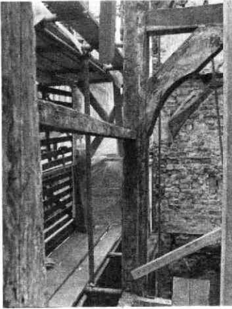
afb. 7 Het houtskelet vóór,
