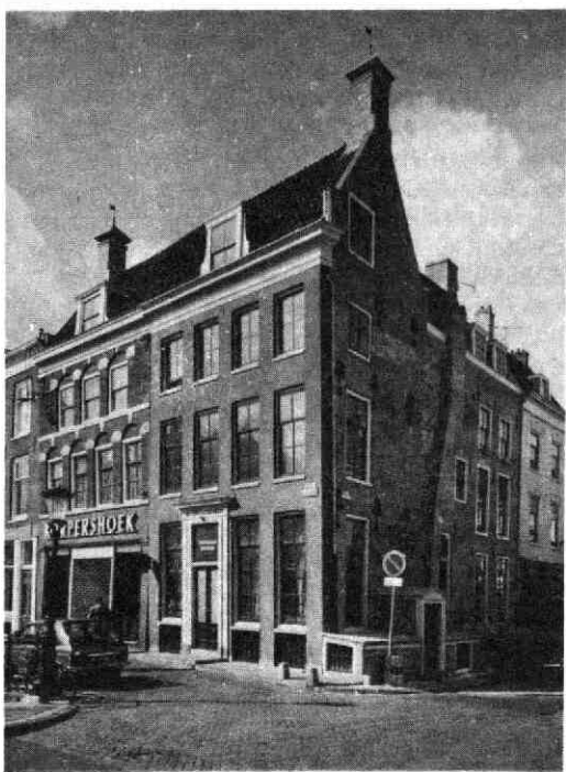
Oudegracht 279 na restauratie.
