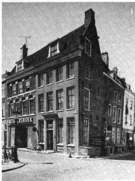
Oudegracht 279 vóór restauratie.
