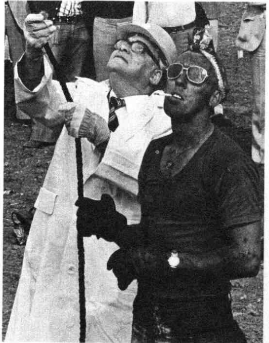
Gedeputeerde Letscher drijft de eerste heipaal voor het toekomstig Provinciekantoor in de vette kleigrond van Rijnsweerd. (Foto: David van Dijk)
