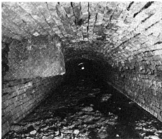
Afb 43. Mariaplaats. Het grote riool aan de noordzijde vóór de schoonmaak. Bij het zien van deze afbeelding kan men zich voorstellen dat er fabeltjes over onderaardse gangen in Utrecht ontstaan. Het riool is 1.25 m hoog en heeft geen bodem.
