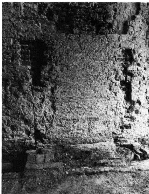
Afb 47. Oude Kamp 7. Haard in de voorkamer. In de muur is de begrenzing van de oorspronkelijke haard te zien. Links op de voorgrond de overdekte goot en rechts de restanten van de haardpot in de goot.
