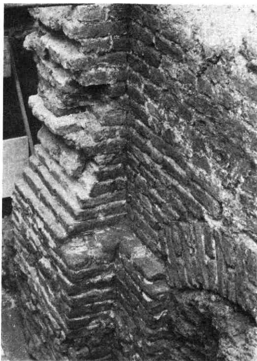
Afb 32. Lange Nieuwstraat, Catharijne Convent. Boogaanzet (links) aan het noordeinde van de oostelijke kloostergang voor de nooit gemaakte noordelijke arm. Rechts de fundering van de oostelijke kloostergang.
