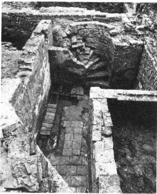
Afb 9. Achter Clarenburg 11-13-15. De wenteltrap in de kelder van nr. 15. Langs de wand de drainage gootjes. De kap van de put bevindt zich onder de hoek van de 18e eeuwse inbouw.
