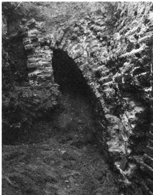
Afb 41. Mariaplaats. Restanten van de brug over de sloot van St. Marie tegenover de Zadelstraat. Rechts de aansluiting van de boog van de brug op de westelijke kademuur.
