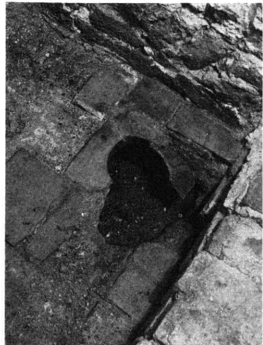
Afb 45. Oude Kamp 7. Haard in de achterkamer met - in situ - de haardpot, die afgedekt is met een plavuiz met een rond gat.
