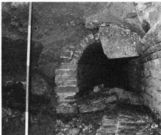
Afb 40. Mariaplaats. Riool dat tijdens de demping van de sloot van St. Marie gemaakt is. NB de verschillen in steenformaat en de ingraving die men gemaakt heeft toen men in de 18e eeuw de kap hermaakte. De grondlagen tegen de wanden lopen echter door, zodat het waarschijnlijk is dat het riool gemetseld is in de half gedempte gracht, die daarna verder aangevuld is.
