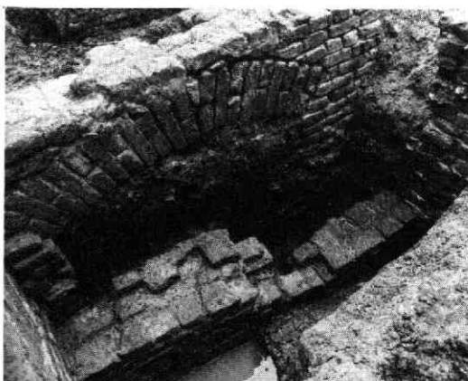
Afb 6. Achter Clarenburg 11-13-15. Scheidingsmuur met spaarboog tussen nrs. 15 en 13 met op de voorgrond de zuidelijke muur van het oude noordelijke huis. Rechts verdwijnt de muur onder de kelder van nr. 15.
