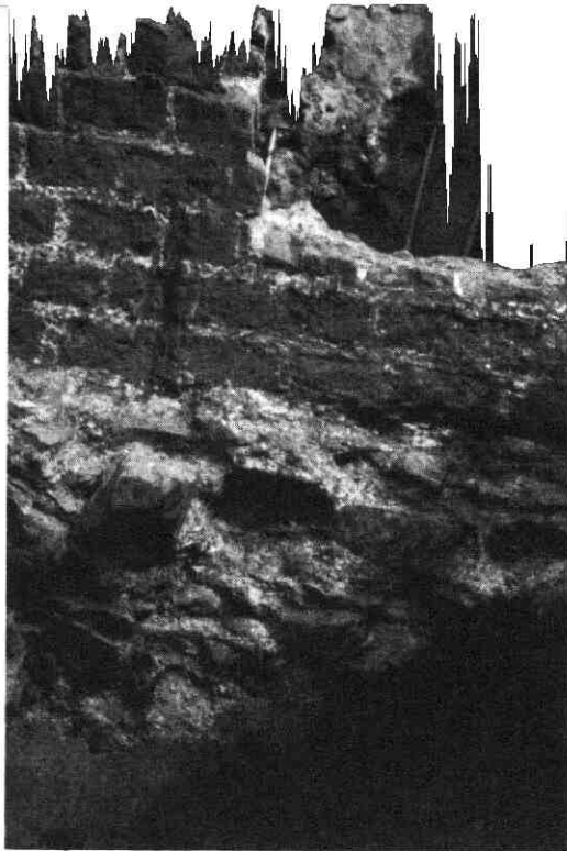
Afb 19. Domplein e.o. Buitenzijde van de castellummuur in Achter de Dom. De plint is alleen aan de buitenkant van de muur aanwezig. De vroeg-middeleeuwse herstellingen zijn herkenbaar aan de onregelmatige stenen en het slechte voegwerk.
