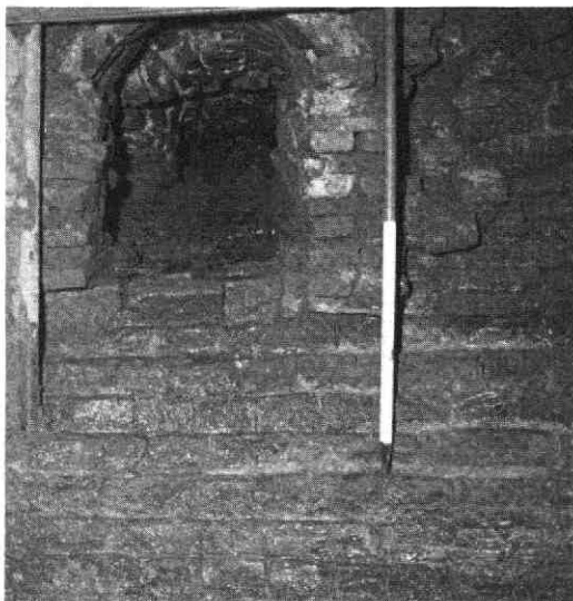
Afb 13. Van Asch van Wijckskade. Uitgang van het riool uit 1545.
