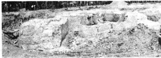
Afb. 54 Vredenburg. De noordmuur van het kasteel; gezien naar het oosten. Links de dikke buitenmuur, rechts de sluitmuur; daartussenin de - inmiddels weggehaalde - aardvulling. De verzakking en scheuring van de zeskantige geschutskelder is goed zichtbaar.
