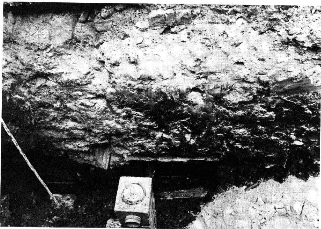
Afb. 24 Oudkerkhof. Beschoeiing of grondkering in de zuidwand van de rioolsleuf; gezien naar het zuiden.
