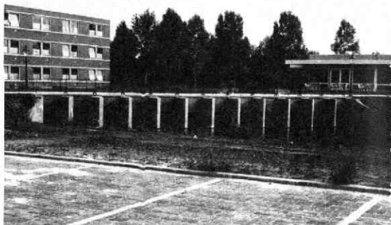
Gerestaureerde brug van 12 gaten op het terrein van de Kromhoutkazeme. (Foto: auteur)
