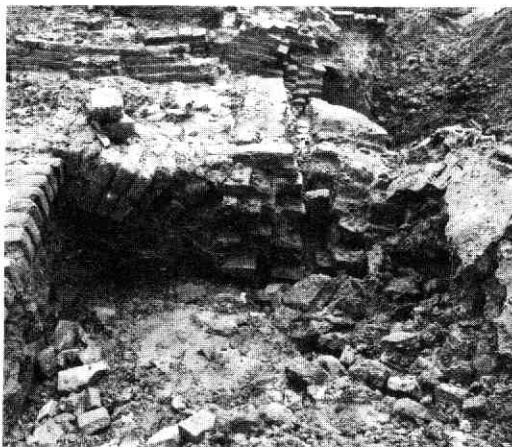
Afb. 32 Steenweg (HEMA). Resten van de scheefgezakte achtermuur van het grote huis aan de Lauwersteeg; gezien naar het zuiden. Op de voorgrond een grondboog van een latere scheidingsmuur in dit grote huis.
