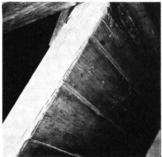
Afb. 2. Het gotische beschoot op de trap (foto D. S. v. Dorsser Keus).
