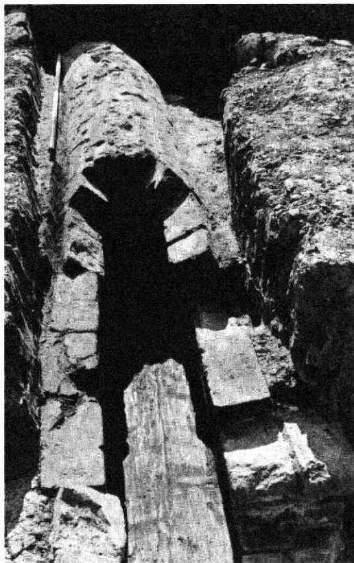
Afb. 49 Vredenburg. Overwelfde bakstenen goot met houten bodem; gezien naar het westen.
