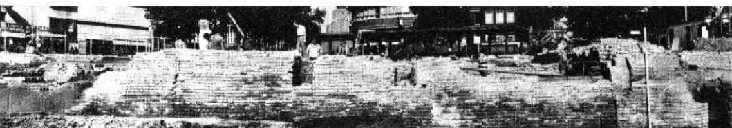
Afb. 46 Vredenburg. Westmuur van het hoofdgebouw van het klooster; gezien naar het oosten. Links: secundair verwerkte tufsteen; midden: ongelijke funderingshoogte; rechts: de dikte van de zuidelijke muur.
