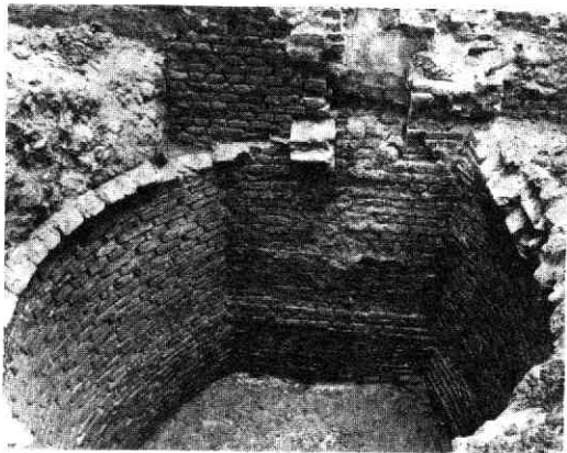
Afb. 20 Minrebroederstraat 2. Beerput; gezien naar het zuiden. Links van de stortkoker is de aanzet van een gemetselde boog zichtbaar, die diende om een muur over de put heen te steunen.
