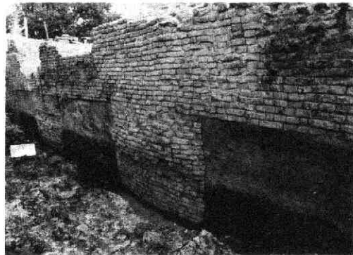
Afb. 47 Vredenburg. Hoofdgebouw van het klooster. Fundering op poeren van de zuidmuur; gezien naar het zuidoosten. De donkere lagen naast en onder de poeren bestaan uit veen.
