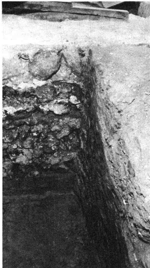
Afb. 12 Janskerkhof (Janskerk). Koppelfundering aan de westzijde van de kruising; gezien naar het oosten.
