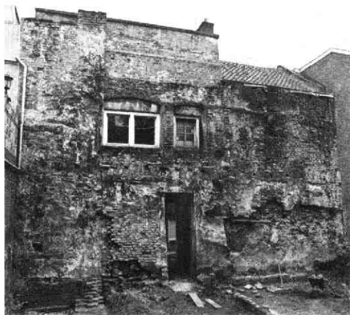
Afb. 23 Hekelsteeg 7-9-11. Overzicht van de achtermuren van de drie huisjes gezien naar het oosten. Links het zuidende van de oostelijke muur van Rozendaal, rechts de zeer verhaspelde oostmuur van de achterbouw. Linksonder de aanzet van de zuidmuur van Rozendaal.
