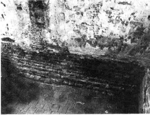
Afb. 83 Springweg 110-130 (Myropskameren). Springweg 120: de verdiept aangelegde vloer van de opslagruimte, gezien naar het zuidoosten.
