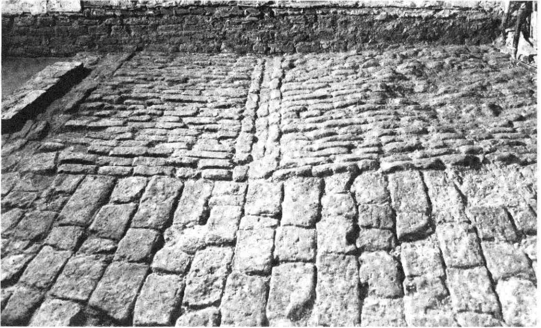
Afb. 85 Springweg 110-130 (Myropskameren). Springweg 114: de vloer van de paardenstalling gezien naar het zuiden. Links in de hoek een stuk van de drinkbak. In het midden het afvoergootje en rechts de uitgesleten plekken waar het paard stond. De muur op de achtergrond dateert uit 1583 en staat op de stallingsvloer.
