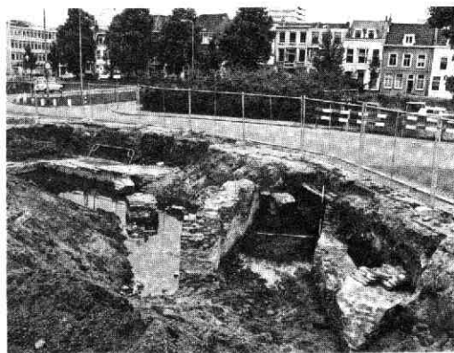
Afb. 38 Jan Meijenstraat e.o. Restanten van het bastion Morgenster gezien naar het noordwesten. Geheel links de fundamenten van de in de 16e eeuw herstelde stadsmuur. Links van en midden in de westelijke gang van het bastion staan funderingspoeren van het Waaggebouw dat na afbraak van Morgenster op die plaats gebouwd werd. Geheel rechts een klein deel van de middelste gang.
