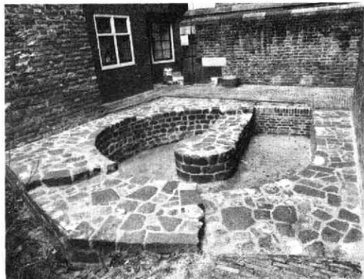
Afb. 76 Servetstraat 7. Tufstenen fundament van de romaanse (trap)toren na restauratie, gezien naar het noordwesten. Op de achtergrond de zuidkant van de voet van de Domtoren. Achter het bakstenen muurtje rechts in het trapfundament bevond zich het afval.
