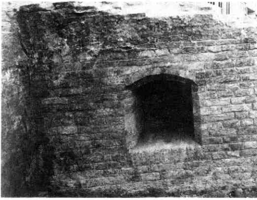
Afb. 99 Vredenburg. Geschutskelder in de oostmuur van het kasteel. Nis in de noordmuur van de middelste ruimte van de achterbouw, gezien naar het noorden. De verzakking van het muurwerk is zeer duidelijk waarneembaar, evenals de scheur die dat veroorzaakt heeft bij de verbinding met de achtermuur (links).
