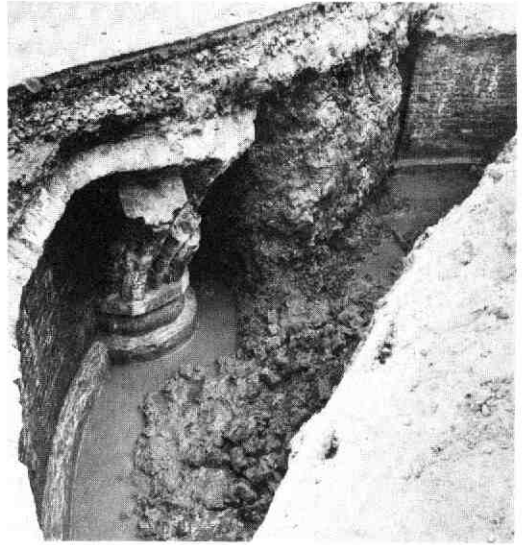
Afb. 100 Vredenburg. Vlaamse toren. Overzicht van een deel van het interieur van de onderste verdieping gezien naar het noordoosten. Het is niet duidelijk geworden waarvoor de nis (waarvan op de achtergrond de rechter zijkant te zien is) gediend heeft of wat voor vorm hij had.
