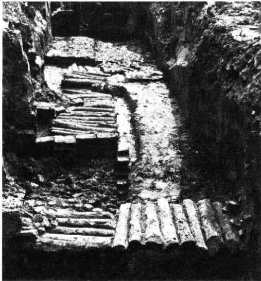
Afb. 39 Jan Meijenstraat e.o. Fundament van het 12e eeuwse gebouw gezien naar het zuiden. Linksonder de ingeheide paaltjes en nog een paar veldkeien.
