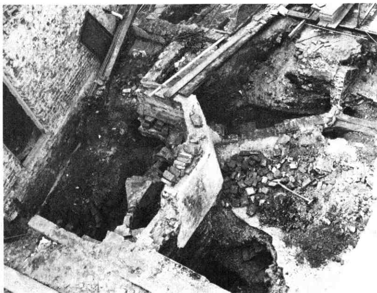
Afb. 4 Achter St Pieter 8. Overzicht van de fundering van de traptoren gezien naar het zuidwesten. Links het zuidelijk blok van het L-vormige huis, onder de aanzet van het oostelijk deel. Het rechthoekig gedeelte aan de westzijde van de traptoren vormt de toegang tot een kelder of sousterrain. Rechts van de traptoren: kelders uit later tijd.
