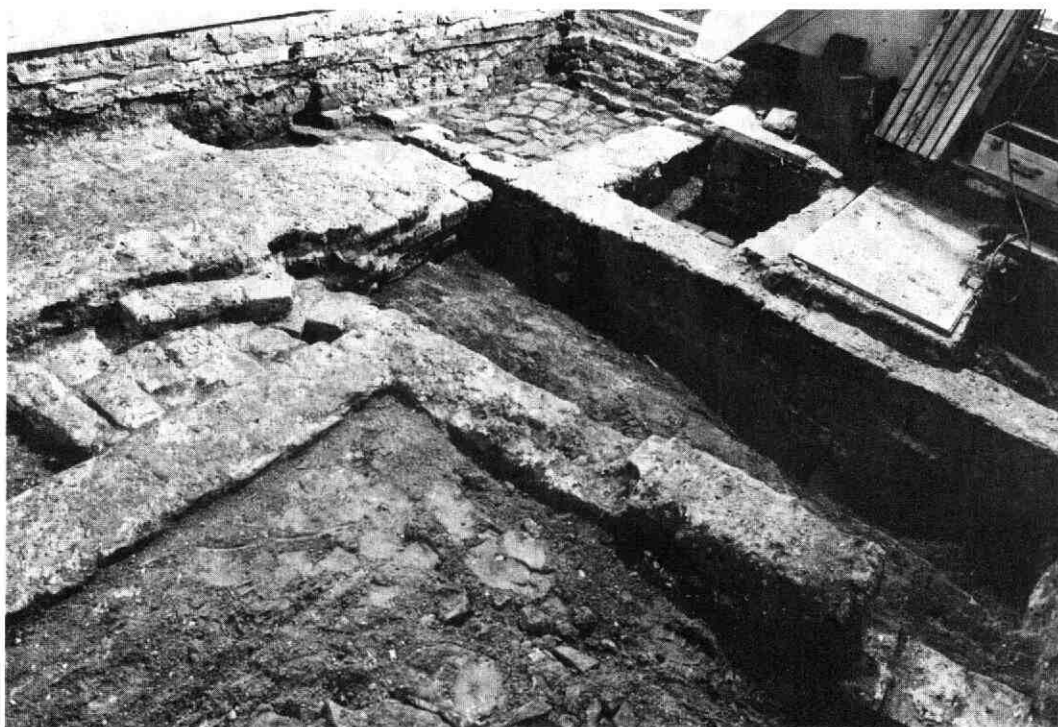
Afb. 88 Springweg 110-130 (Myropskameren). Springweg 110 gezien naar het noordoosten. Funderingen van de traptoren (rechtsboven) en van de oven (voorgond). In de hoek linksachter ligt nog een stukje buitenbestrating. Daar is ook de verzakking van de achtergevel goed te zien.
