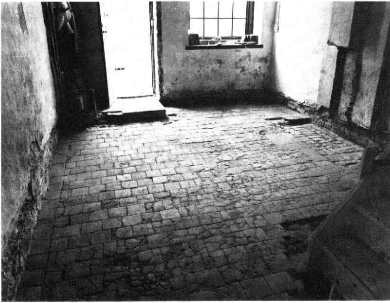
Afb. 91 Springweg 110-130 (Myropskameren). Springweg 112: de vloer van 1583 gezien naar het westen. Het slijtage patroon is duidelijk te zien, evenals de herstelling bij de stookplaats.
