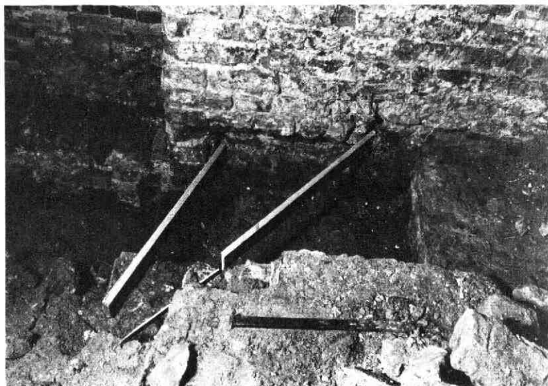
Afb. 89 Springweg 110-130 (Myropskameren). Springweg 110: projectie van de eerste treden van de traptoren aan de hand van de teruggevonden sleuven van de stootborden, gezien naar het zuidoosten. De donkere baan tussen de twee latten is een sleuf van de eerste trede. Links is de drempel van de doorgang zichtbaar, rechts nog net de fundering van de westwand.
