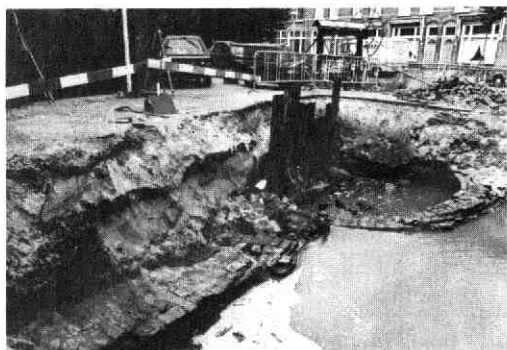
Afb. 19 Gruttersdijk. Overzicht over de fundamente van het ronddeel Simpoel en over een deel van de oostelijke muur van de Bemuurde Weerd gezien naar het noordwesten.
