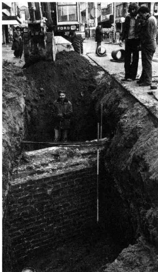
Afb. 95 Vredenburg. Singelmuur tegenover de Vlaamse toren van het kasteel, gezien naar het oosten. Deze zijde van de muur was naar het water van de gracht gekeerd en is duidelijk goed afgewerkt.
