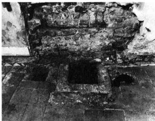
Afb. 93 Springweg 110-130 (Myropskameren). Springweg 110: twee vroeg 18e eeuwse haardpotten en een latere asput, gezien naar het zuiden. In de muur erboven is nog de bodemlaag van een oorspronkelijke ovenopening te herkennen.
