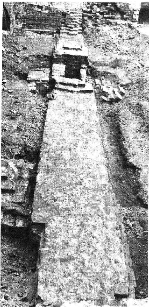
Afb. 24 Hekelsteeg 7-9-11. De zuidelijke achtermuur van Rozendaal gezien naar het oosten. De dichtgezetste doorgang naar de kelder en de resten van keldermuren en -gewelven zijn zichtbaar.
