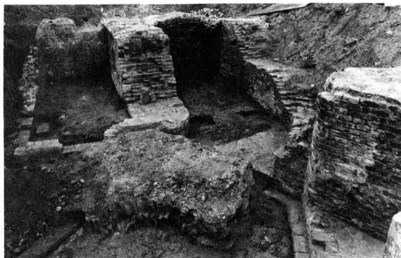
Afb. 98 Vredenburg. Geschutskelder in de oostmuur van het kasteel, achterbouw gezien naar het noordwesten. Op de voorgrond de restanten van het ingestorte gewelf. Rechts de kanongang met een duidelijk waarneembare scheur in de rechter muur en de over de in de gang gegooiden grond heen gemetselde boog.
