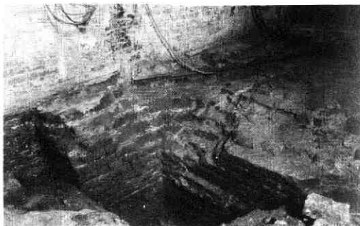
Afb. 14 Domplein (Domkerk). Zware fundering in het zuidoost portaal gezien naar het noordwesten. Rechtsachter de ingang naar de kerk. Geheel links de muur die over het fundament heen gebouwd is.
