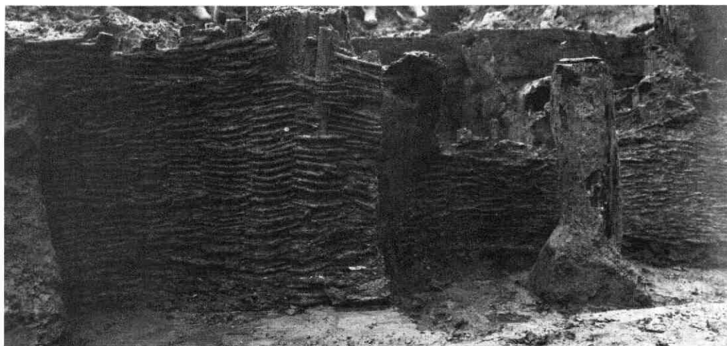
Afb. 29 Jan Meijenstraat e.o. Beschoeiing van vlechtwerk gezien naar het noorden, dus naar de rivier toe. Duidelijk is te zien hoe het rechter gedeelte door gronddruk (en onderspoeling?) verder naar de rivier is gezakt dan het linker gedeelte.
