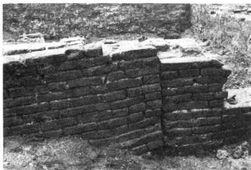
Afb. 35 Jan Meijenstraat e.o. De aansluiting tussen het grote en het kleine achterhuis op perceel 1, gezien naar het oosten. Hieruit blijkt dat beide delen niet tegelijk zijn gemetseld. Toch hoeft de tussenliggende tijd - gezien het karakter van het metselwerk - niet erg lang geweest te zijn.
