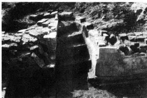
Afb. 120 Vissersplein e.o. Het trapje van huis XII is duidelijk jonger dan de muur, het is door de grondbog, waarvan links en rechts nog aanzetten te zien zijn, gebroken. Bovenaan het trapje is nog net het afsluitende muurtje, over de treden heen, te zien. Foto H. L. de Groot.
