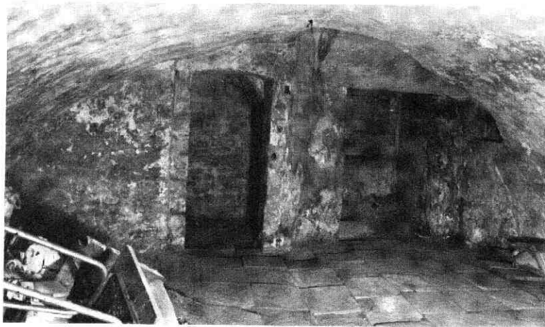
Afb. 72 Mariaplaats 9. De middeleeuwse kelder gezien naar het oosten. Links: de doorgang naar het kleine keldertje. Rechts: de vroegere ingang. Op de vloer: natuurstenen plavuizen.
