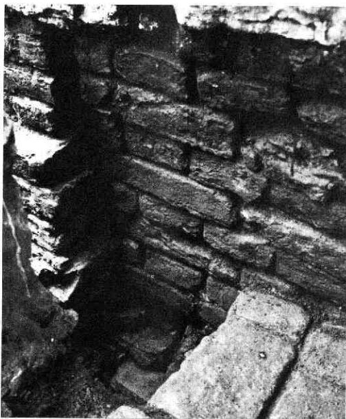
Afb. 104 Springweg 130-130bis. Het oosteinde van de zuidmuur, gezien naar het zuidoosten, met het doorgesakte metselwerk van de vroegere hoek met de achtergevel. Aansluitend naar het oosten: de fundering van de latere erfscheiding.
