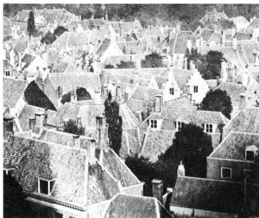
Afb. 7 Achter St Pieter 8-10-12. Gezicht vanaf de Domtoren in de richting van Achter St Pieter 8 en 10. In de kappenstructuur (aangegeven met inktlijnen) is de opzet van het complex te herkennen. Foto W. C. van Dijk, ca. 1870. GAU TA Ca 2. Tek. A. F. E. Kipp.
