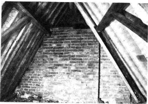
Afb. 77 Mariaplaats 9. De buitenzijde van de noordmuur naar het zuiden gezien vanaf de vloering boven Mariaplaats 10. Goed zichtbaar is het pleisterwerk van de oorspronkelijke (lagere) kap van Mariaplaats 10. In het metselverband van de schoorsteen is het tussenschot daarin herkenbaar.
