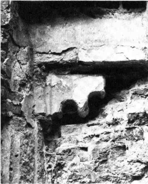
Afb. 129 Oude Gracht 245 e.o. De console in de linker bovenhoek van het oorspronkelijke noordportaal van de Regulierenkerk.
