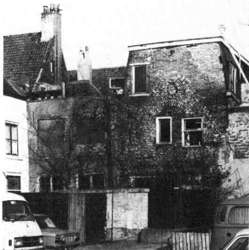
Afb. 45 Jacobijnenstraat 3-15. De middeleeuwse achtergevel van nr. 7 met latere verhogingen.
