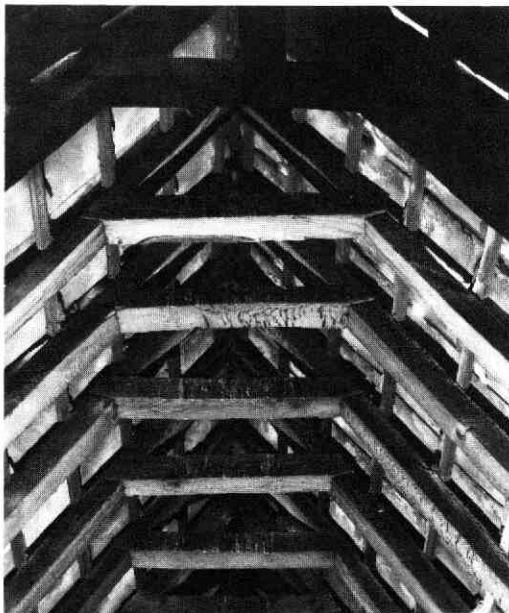
Afb. 126 Oude Gracht 245 e.o. Bovenste gedeelte van de eiken sporenparen met telmerken van het huis Roghmuscaet (1413).
