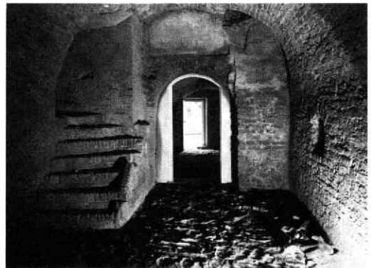
Afb. 112 Oude Gracht 199. Gezicht in de kelder met de onderbouw van de voorgevel en de keldertap naar de straat. In de trap: secundair verwerkte gebeeldhouwde fragmenten van een gotische schouw (zie afb. 113).
