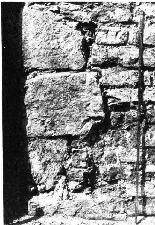
Afb. 11 Boterstraat 20. Detail van de hoekafwerking met natuursteenblokken aan de achterzijde van de oostmuur. Foto Jean Penders.
