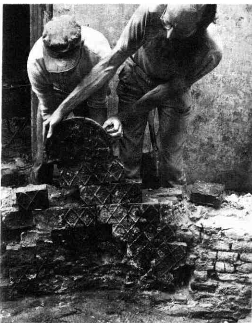
Afb. 179 Zilverstraat 14. Stookwand met haardstenen, die oorspronkelijk toebehoort heeft aan het achterhuis van Zilverstraat 12.
