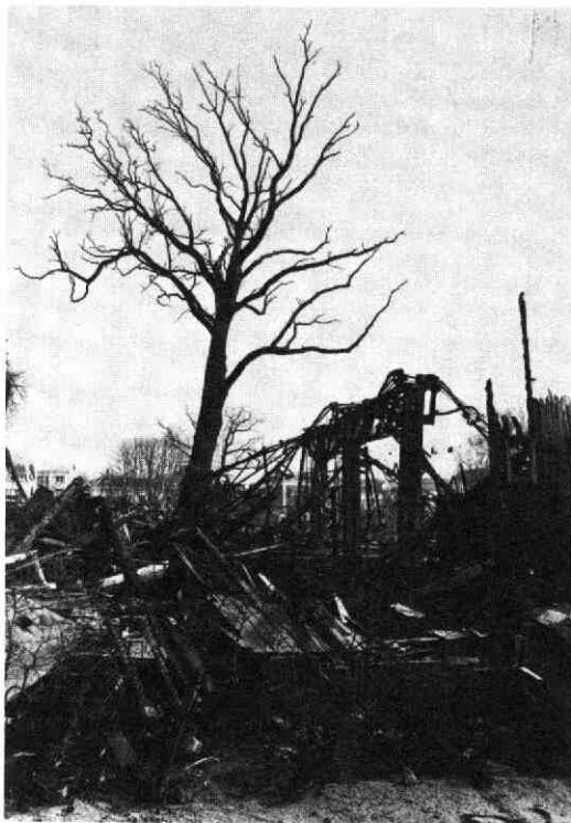
Restanten van het noodgebouw, een dag na de fatale brand, 1979.
