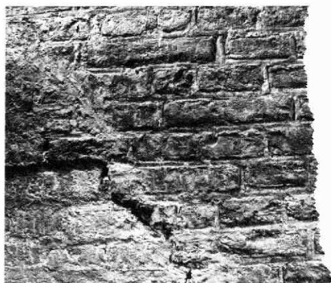
Afb. 82 Mariaplaats 9. Detail van het metselwerk van de noordmuur (vroegere buitenzijde). On. links: een fragment van de verhoging van bouwphase 2. Het overige muurwerk (bouwphase 3) vertoont een verschil in afwerking ter weerszijden van de dakmuur van de vroegere kap van Mariaplaats 10.
