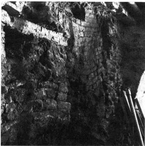
Afb. 106 Oude Gracht 136. Gezicht op de tufstenen en bakstenen funderingen in het verlengde van de zuidmuur van Honenburg.
