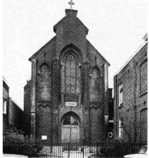
De voorgevel van St. Jakobus buiten de Weerd vanuit het zuidwesten. Links beneden is de eerste steen aangebracht, gelegd op 4 mei 1870 door de oud-katholieke aartsbisschop Henricus Loos. (GAU T.A. Kc 2.2)
