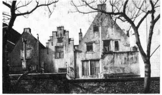
Afb. 121 Oude Gracht 242-244, 260-262-264, 284. De middeleeuwse achtergevels van de huizen 244, 242 en 240, met aanduiding van de contour van de gekanteelde trapgevelvorm van nr. 242.
