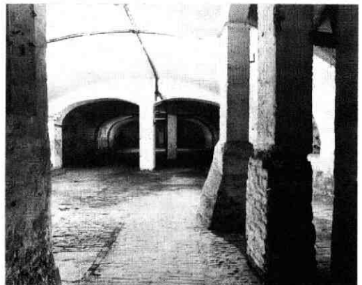
Afb. 130 Oude Gracht 270. De kelder naar het oosten gezien.
