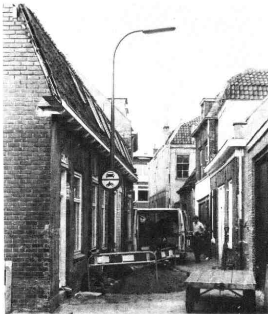
Renovatie van een huizenrijtje (links) in de Flieruilensteeg. Foto: P. Smiesing.
