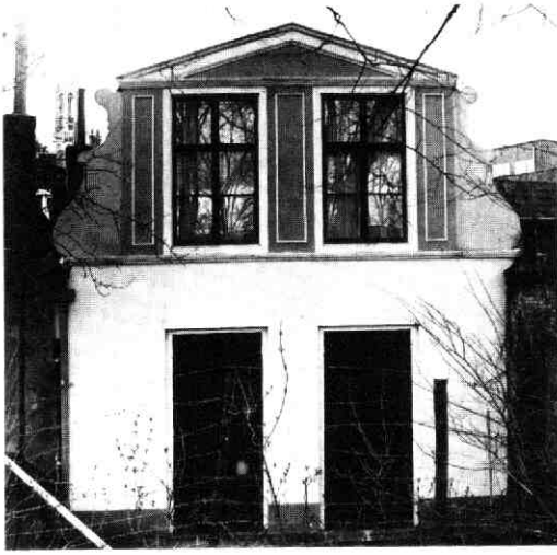
Afb. 180 Nobeldwarsstraat 18. Achtergevel met houten opbouw, na herstel.
