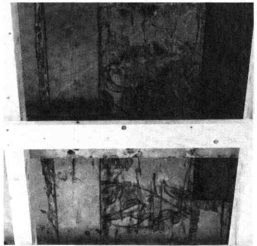
Afb. 242 Springweg 16. Detail van de 17e-eeuwse plafondbeschildering op de verdiepingsbalklaag van het voorhuis.
