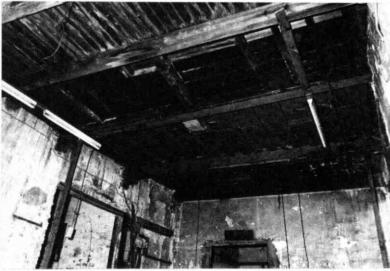
Afb. 55 Gasthuisstraat 89. De vroeg 17e-eeuwse balklaag met de forse sleutelstukken.
