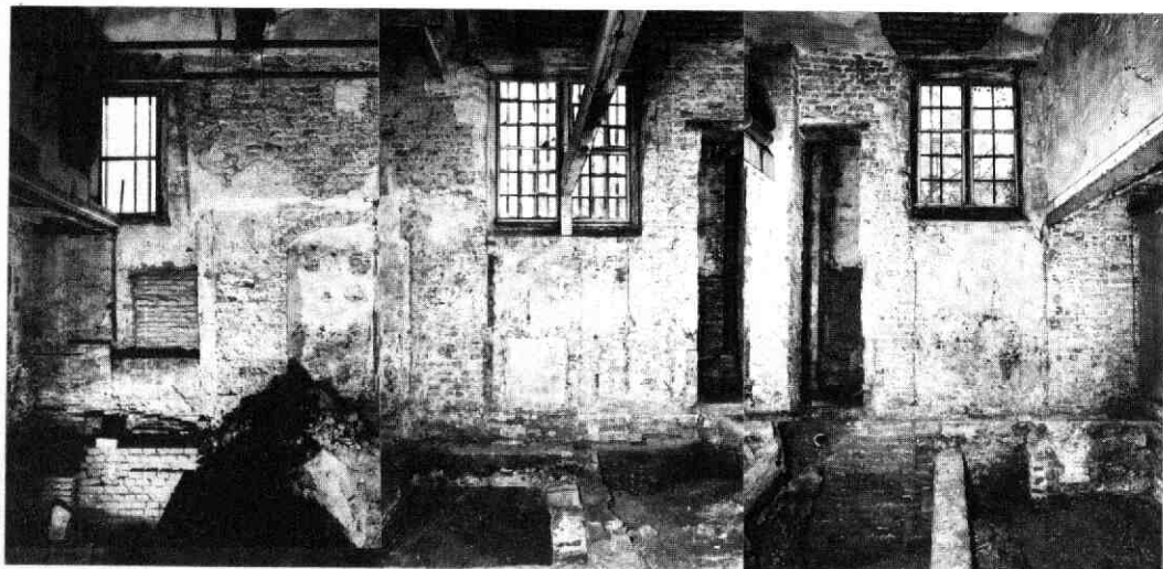
Afb. 10 Abraham Dolesteeg 10. Montage-foto van de noordmuur. Herkenbaar zijn de twee middeleeuwse ingangen: links met boog, rechts met doorgebroken boog onder het rechter venster. De twee linker vensters bevinden zich op de plaats van de (grotere) oorspronkelijke vensters. Helemaal rechts eindigt de noordmuur met het hoekverband van een derde middeleeuws venster. Achter de ronde bult van de 17e-eeuwse waterput (rechts van het midden) is in de fundering een rest van de afgebroken 15e-eeuwse scheidingsmuur te zien. Zie ook de tekeningen.
