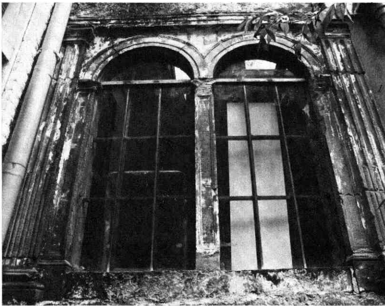
Afb. 148 Mariaplaats 22. Het zandstenen venster in de vroegere voorgevel, die thans achtergevel is. Rechts sloot onder een hoek van 90° oorspronkelijk eenzelfde venster aan.
