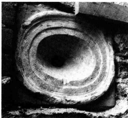
Afb. 171 Nieuwe Gracht 51. 17e-eeuwse geprofileerde steen met een zeer klein oeil de boeuf (achtergevel A).
