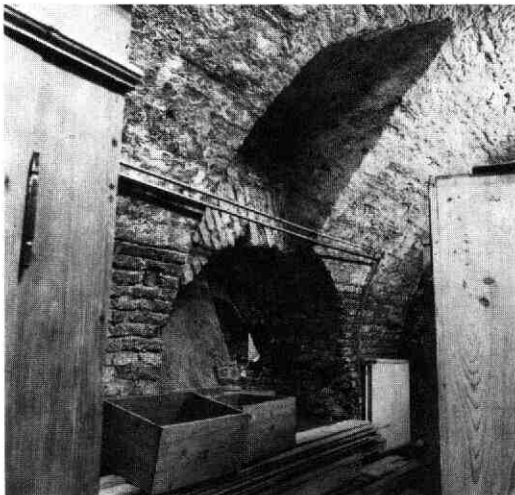
Afb. 205 Oude Gracht 140, 142. Een als doorgang naar de zijkelder gebruikte spaarboog van het funda- ment van Oude Gracht 142.
