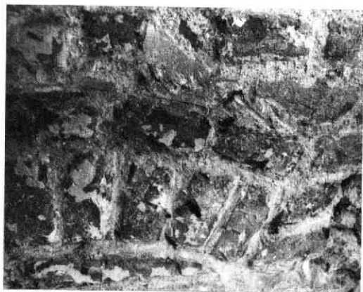
Afb. 95 Jeruzalemstraat 8-10. Detail van de boog van het gedeeltelijk zandstenen traptorenvenster met het voegwerk met de dubbele dagstreep.
