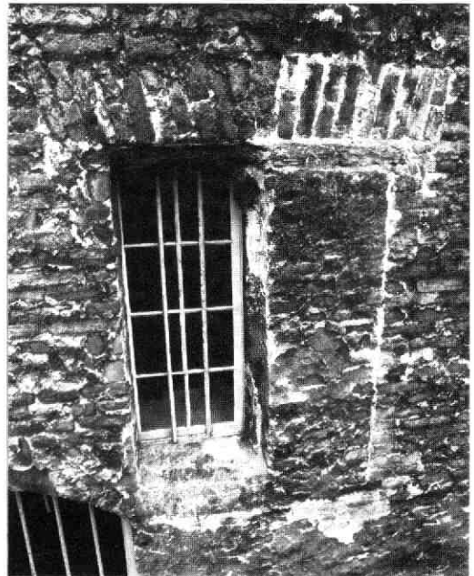
Afb. 153 Oude Gracht 113. Het 13e-eeuwse venster in de noordgevel op de verdieping.
