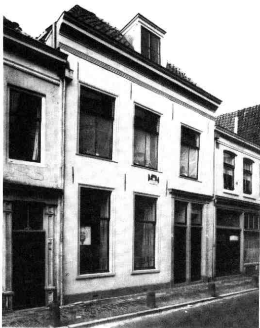
Afb. 188 Springweg 69-71. Toestand na de restauratie. De gevelsteen is weer in zijn originele kleuren geschilderd.
