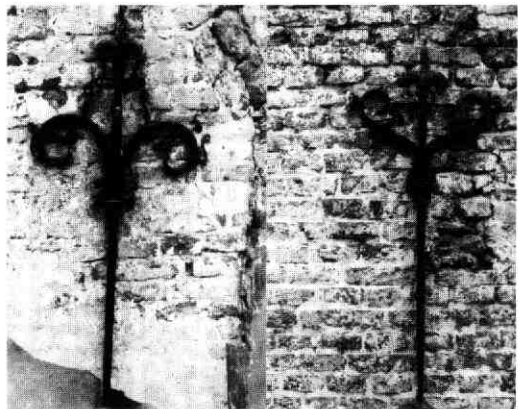
Afb. 180 Pauwstraat 30. Vroeg-renaissance ankers van de beganegrond (links) en van de verdieping (rechts).
