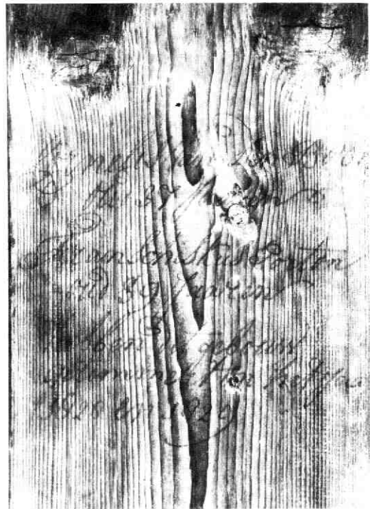
Afb. 28 J. P. Coenstraat 5. Signatuur van de bouwers van de nieuwe vleugel aan het molenaarshuis (1828-1829) op de achterkant van de betimmering.
