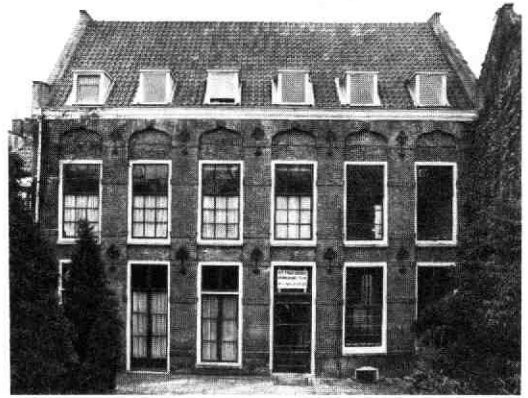
Afb. 100 Kromme Nieuwe Gracht 46. De gevel aan de tuinzijde. Al het sierwerk, zoals banden, sluitstenen en kabelornament, dat gewoonlijk in natuursteen is uitgevoerd, is hier in baksteen gemaakt.
