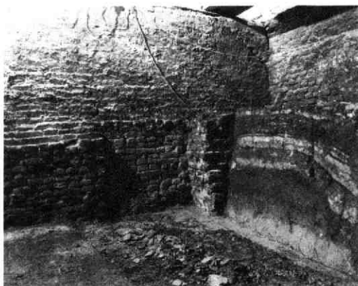
Afb. 130 Oude Gracht 99. De oostelijke muur van het noordelijke achterzijhuis, gezien naar het zuidoosten. Het verschil tussen de rommelige onderkant van de fundering en de wat netter afgewerkte bovenkant is goed te zien.
