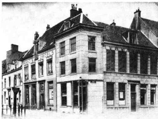
Afb. 84 Kromme Nieuwe Gracht 2. Foto van het huis in 1932, vóór de sloop. GAU TA, KNG 2).
