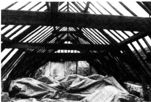
Afb. 195 Springweg 69-71. De 17e-eeuwse, lichtelijk geknikte kap met middeleeuwse spanten.
