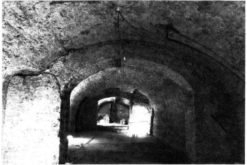
Afb. 159 Oude Gracht 223. Werfkelder, vóorkelder en achterkelder. Op de scheiding van vóor- en achterkelder zijn rechts de treden van een middeleeuwse trap te zien.
