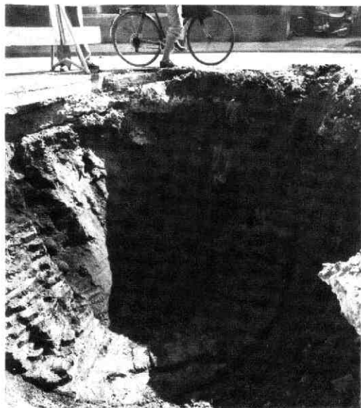
Afb. 201 Twijnstraat. Deel van een ronde toren van de oostelijke Tolsteegpoort (vóór 1550), gezien naar het oosten. In de vulling van de poort zijn links tegen de muur twee stenen kanonskogels te zien.
