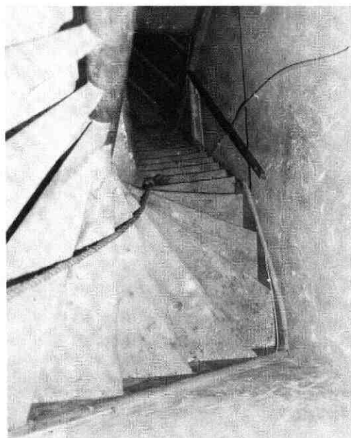
Afb. 11 Achter Clarenburg 5. Trapje van de begane grond naar zolder. Foto Bart Klück. Waar het rechte gedeelte overgaat in een spiltrapje wordt de klim zó steil, dat een touw onontbeerlijk is.
