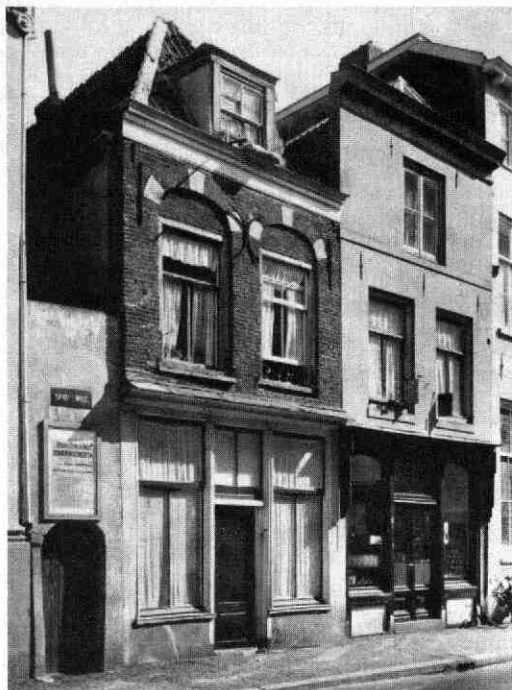
Afb. 238 Springweg 4 en 6. Voorgevels vóór 1968.
