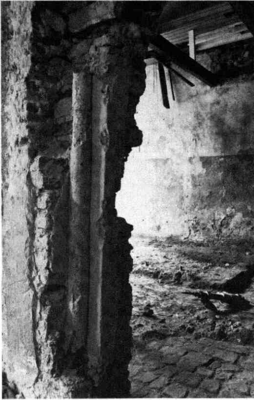
Afb. 95 Kromme Nieuwe Gracht 33. De binnenhoek van de 13e-eeuwse ingang in de noordmuur van het claustrale huis met het karakteristieke rondstaafprofiel.
