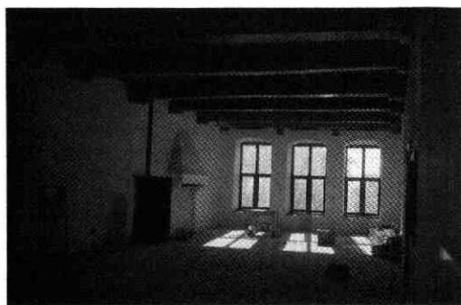
Afb. 189 Oude Gracht 99, Oudaen. De eerste verdieping van het hoofdhuys, naar achteren gezien. Duidelijk valt het kwaliteitsverschil op tussen de moerbalken van de (bewoonbare) achterkamer en die van de (zolderachtige) voorzaal.
