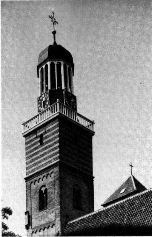
Afb. 175 Nicolaaskerkhof, Nicolaastoren. De toren na de voltooiing van de restauratie.
