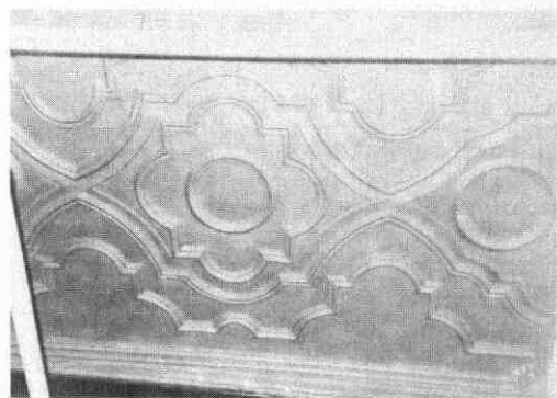
Afb. 78 Keizerstraat 35. Een voorbeeld van het in de tekst beschreven stucplafond, gezien in het voormalige Cellebroedersklooster te Mechelen (B). Foto Jan van der Hoeve.
