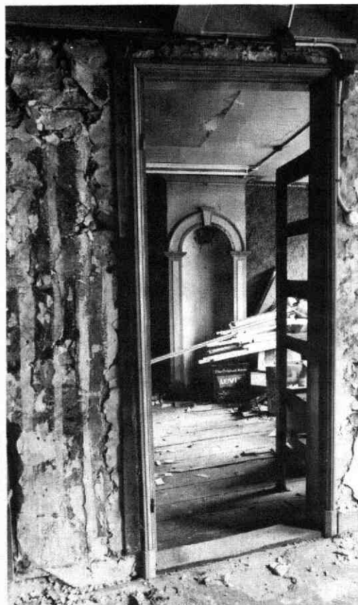
Afb. 109 Lange Elisabethstraat 13. Het schouwttje van 1824 en op de voorgrond links het „behang” uit dezelfde tijd: rode verfbanden op de gewitte muur.
