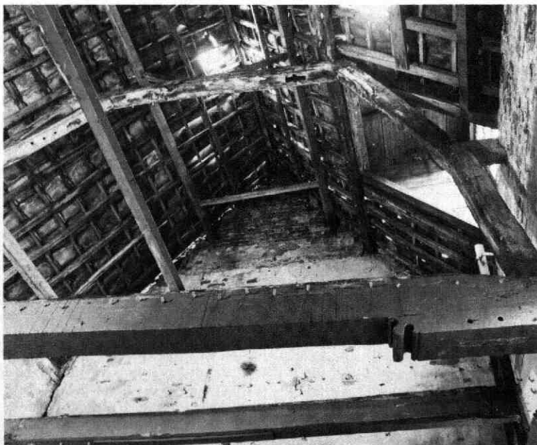
Afb. 71 Geertekerkhof 2. Doorkijk naar de kap met rechts een 15-eeuws sleutelstuk waarin pengat en toognagelgaten van een korbeel zitten. Links boven is het korbeel van het spant te zien dat oorspronkelijk een deel van een muurstijl was (met toognagelgaten).
