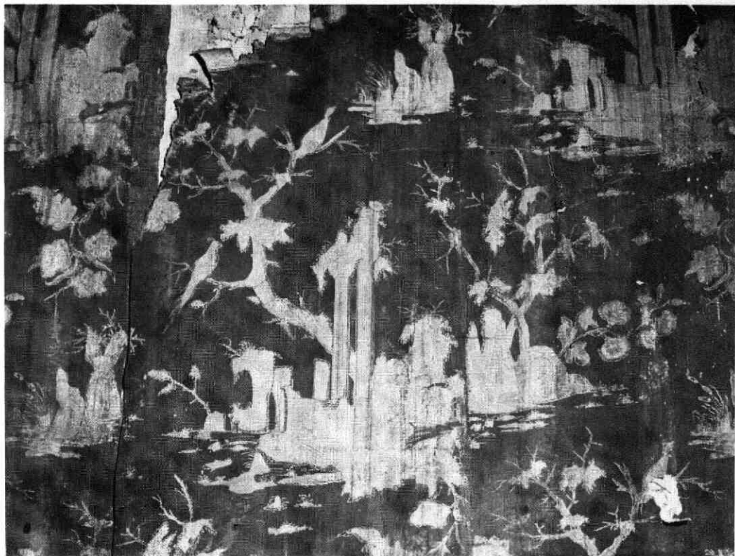
Afb. 209 Oude Gracht 179. Detail van het helderblauwe papierbehang uit het derde kwart van de 18e-eeuw. Het zijn handgedrukte vellen die eerst tot banen aan elkaar geplakt werden voor ze op de muur gingen.
