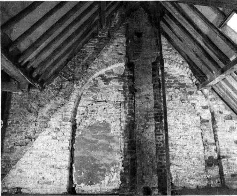
Afb. 98 Kromme Nieuwe Gracht 33. De top van de oostgevel. Duide-lijk is de dubbele spaar-nis te zien met de sporen van zoldervensters en het balkgat bovenin van het blokkeel naar de haanhouten van de eer-ste 4 of 5 sporenparen.
