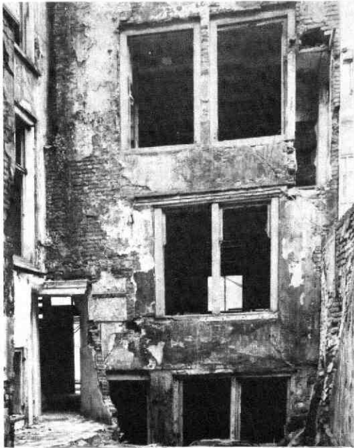
Afb. 241 Springweg 4 en 6. Achtergevel nr 4, eind 1968. Foto H. N. Bol. De zeer smalle ruimte van de hangplee is een halve steen in de zijgevel uitgehakt. De nog aanwezige bovendorpel van het opkamer-venster geeft aan dat dit oorspronkelijk naar links breder was. De kelderkeuken heeft een deur en een bolkozijn. Links is de in nr 4 uitgespaarde doorgang naar nr 6 te zien, waarboven de aansluiting van beide panden.
