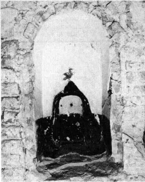
Afb. 101 Kromme Nieuwe Gracht 33. De lavabo-nis geopend met onderin de resten van de waterbak met afvoer. De bak was gemaakt van twee stukken zandsteen die met krammen waterdicht waren verbonden. In de achterwand het tufstenen nisje, bebroond met een 16e-eeuwse vogel.
