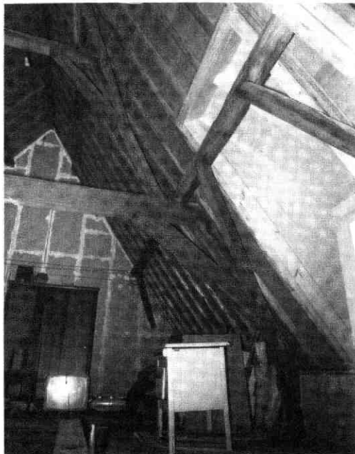
Afb. 59 Jeruzalemstraat 8-10. Detail van de kapconstructie van de oudste vleugel. Het spant heeft geen nokstijl.
