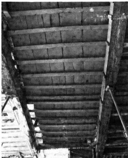
Afb. 185 Twijnstraat 50. Het derde balkvak van de beganegrond met sporen van de middenscheiding en van de ongelijke, brede vloerdelen links en rechts daarvan.
