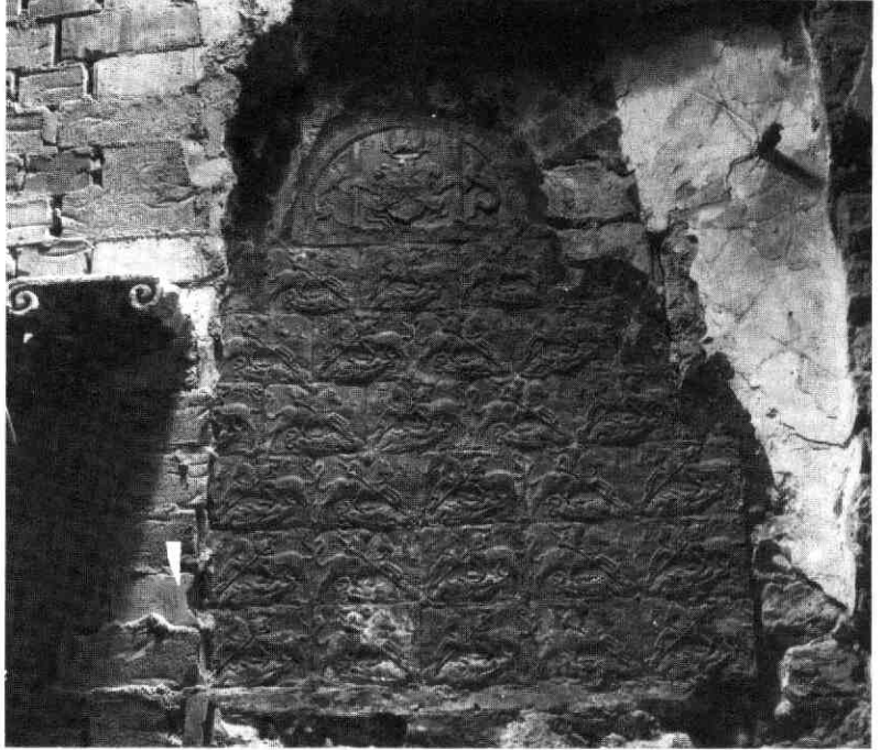
Afb. 189 Twijnstraat 50. De haard van de insteekverdieping aan de noordzijde. Links het teruggelovonden bakstenen kapiteeltje van een wangpilaster.
