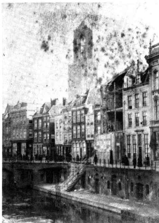
Afb. 131 Oude Gracht 151. Foto van de bouwwerkzaamheden in 1889, waarbij de voorgevel vervangen wordt. De huidige kap en balklagen zijn reeds aanwezig. Het huis is nu twee bouwlagen kwijt. GAU/TA Oude Gracht (Bakkerbrug - Stadhuisbrug) c 1890.
