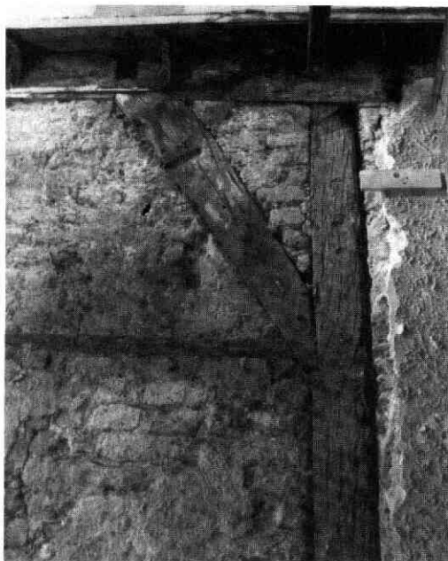
Afb. 37 Geertestraat 14-16. De vakwerkconstructie in de muur tussen nr 14 en nr 16 (achterste deel).
