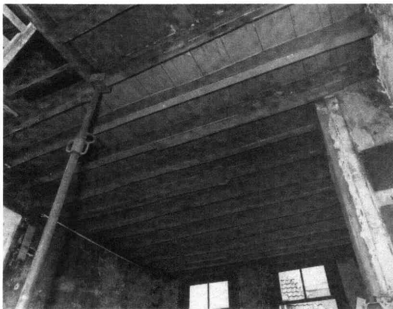
Afb. 44 Geertestraat 26 en 28. De 14e-eeuwse balklaag van de verdieping: eiken en den- nen.
