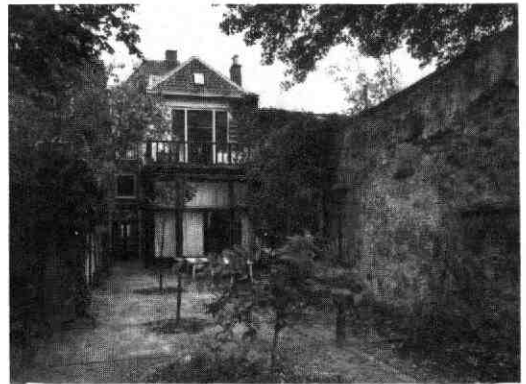
Afb. 72 Korte Nieuwstraat 6. Gezicht vanuit de tuin op het bewaardgebleven deel van de tufstenen kerkmuur (rechts) en op het achterhuis met het mogelijke restant van de gang daarnaast (links).
