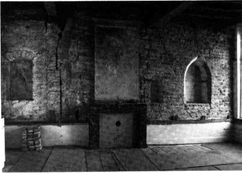
Afb. 106 Oude Gracht 17. Voorkamer op de verdieping met nissen uit de bouwtijd en sporen van een schouw uit de tweede fase.
