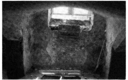
Afb. 63 Jeruzalemstraat 8-10. Detail van de kelder van de achtervleugel, waarop de flauwe kromming van het gewelf tussen de gordelbogen duidelijk uit- komt. Foto Bart Klück.
