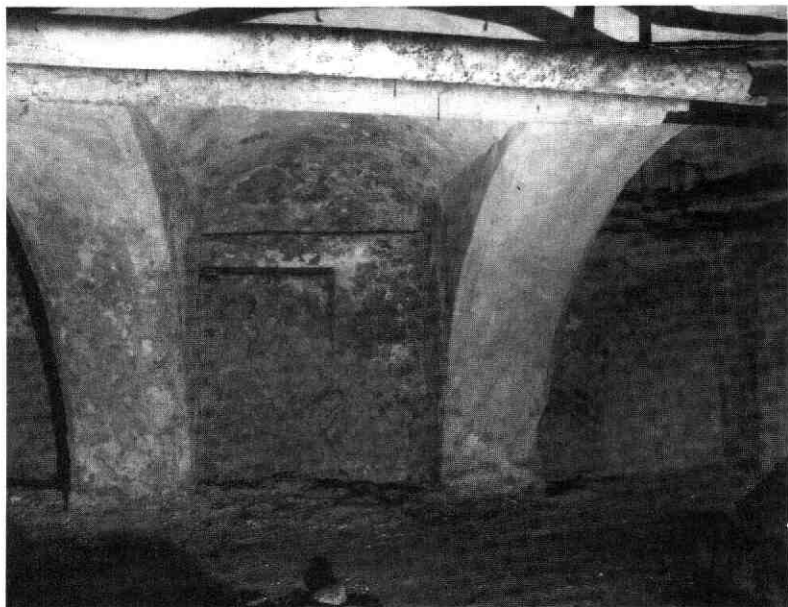
Afb. 117 Oude Gracht 147. De westmuur van de achterkelder met de 13e-eeuwse grondbogen en daarboven de vloerlijn van het oorspronkelijke vloerpeil van de beganegrond.
