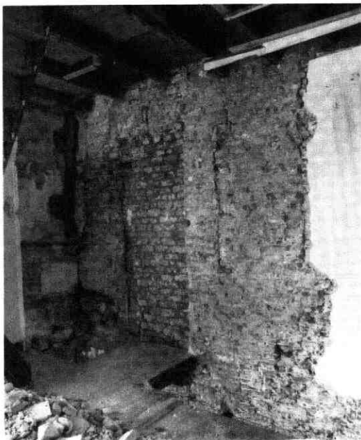
Afb. 49 Geertestraat 26 en 28. De zuidwesthoek van de eerste verdieping van nr 28 met een, voor een deur versmald, 14e-eeuws venster. Rechts daarvan: een hoek en boogaanzet van een nis.
