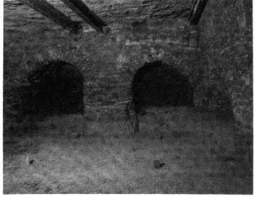
Afb. 84 Neude 1 en 2. Foto van de fundering op spaarbogen onder het voorste deel van nr 1, gezien naar voren, na de ontgraving.
