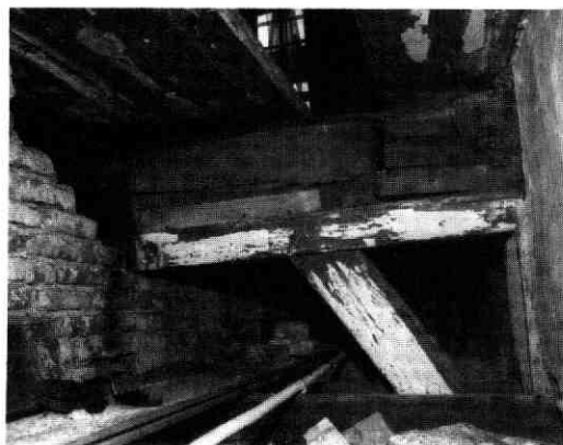
Afb. 180 Twijnstraat 47. Korbeelstel onder de verdiepingsvloer met schildering die ter plaatse van een 17e-eeuwse gangmuur bewaard bleef.
