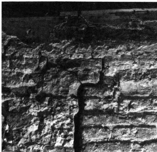
Afb. 150 Predikherenkerkhof 1. Detail van de zuidmuur op de verdieping van het voorhuis met een 14e-eeuws profiel van de daklijst van de in de 16e eeuw afgebroken noordvleugel. Haaks daarop (rechts) de afgehakke daklijst van de kerkmuur uit omstreeks 1500.
