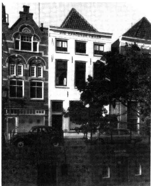
Afb. 113 Oude Gracht 17. Voorgevel na de restauratie.
