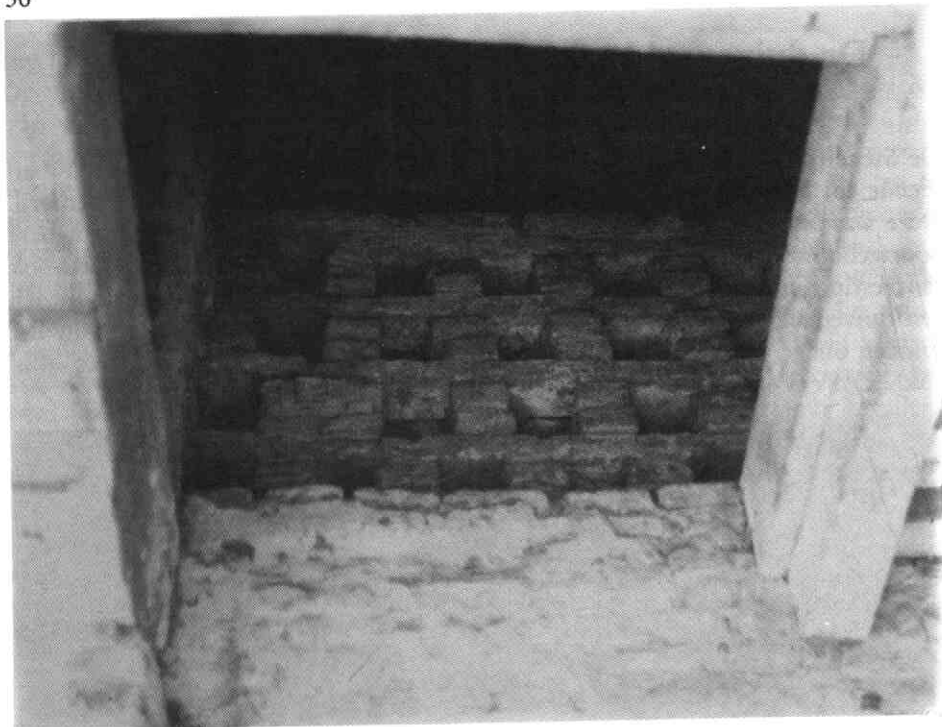
De duivennissen op de zolder van De Stenen Poort
