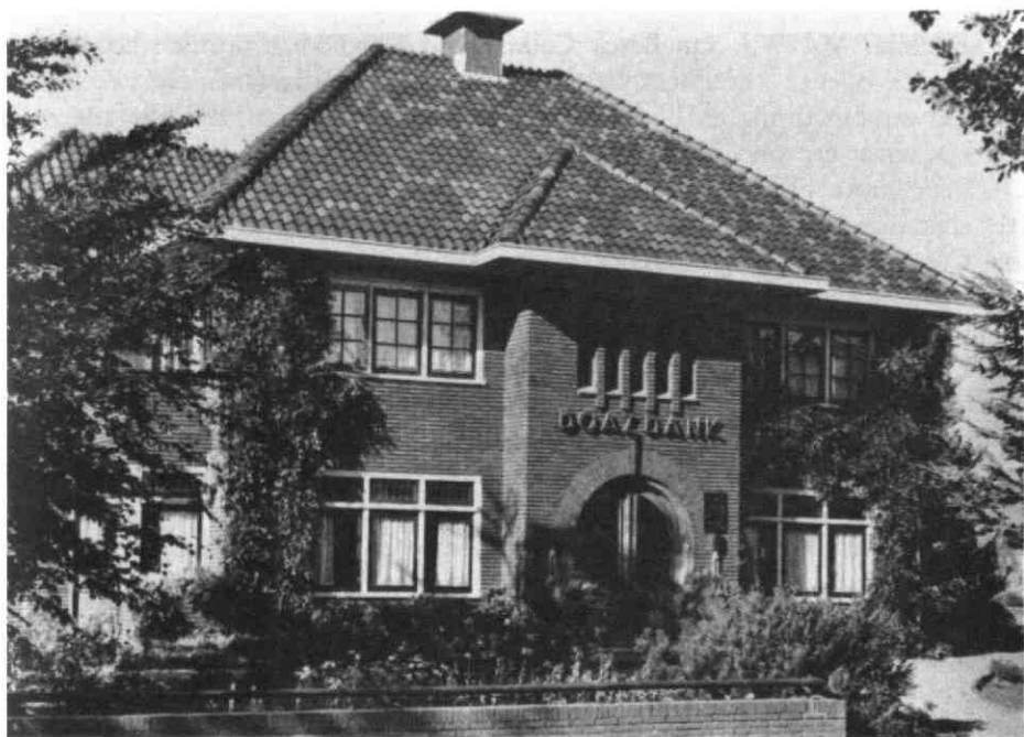
Kantoor van de Boaz-bank aan de Provinciale Grintweg 34 te Bunnik, 1936.
