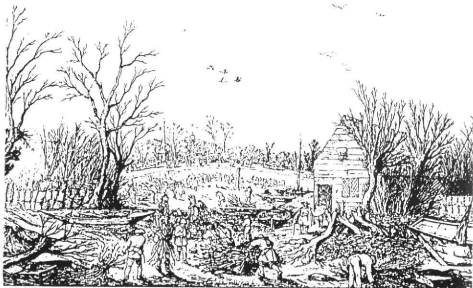
Herstelwerkzaamheden aan de Lekdijk ter hoogte van het Oudslikkerveer na de dijkdoorbraak in 1624. Kopergravure door C.J. Visscher, z.j., naar een tekening van E. van de Velde, vóór 1630 (RAU, TA nr 1978-064)
