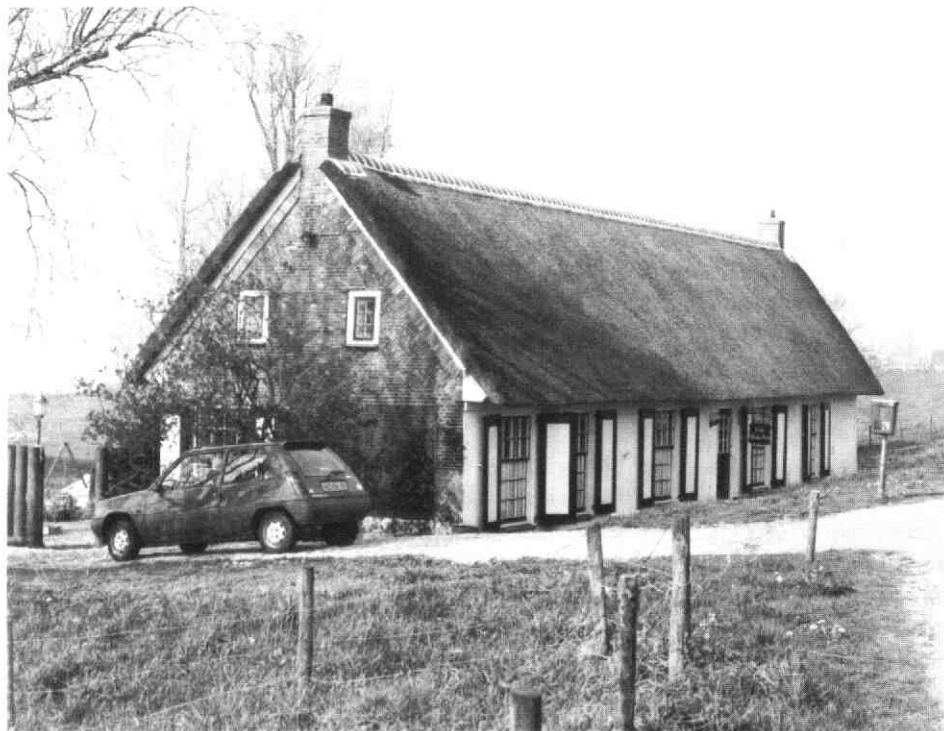
Het buitendijks gelegen Oudslijkerveerhuis, Lekdijk 78 (Foto uit 1990 door O.J. Wttwaall)
