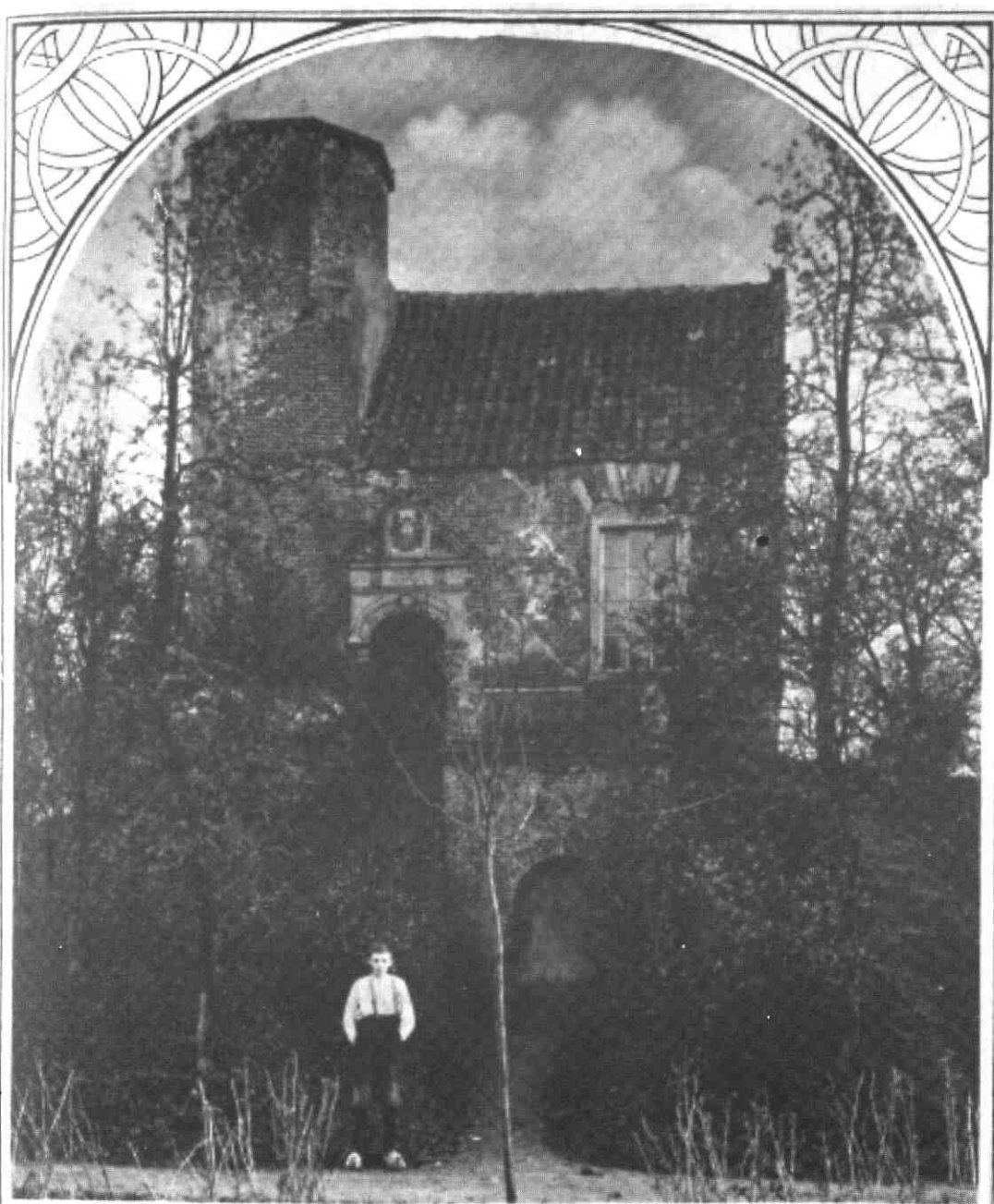
Onder de gemeente Houten rijst, naar den Utrechtschen weg tusschen het geboomte, het huis „Oud-Wulven“ op, dat aan het landschap een bijzondere bekoring geeft. Oorspronkelijk werd dit oude — doch niettemin stevige — gebouw als jachtslot gebruikt.
