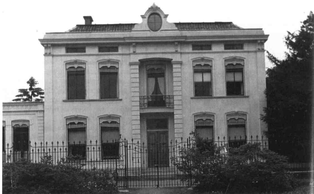
6. De voorgevel van het huis Muntstraat 36
