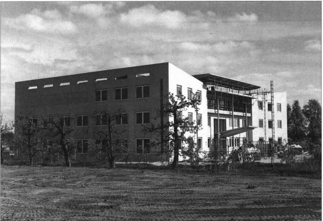
Het in aanbouw zijnde gemeentehuis van Bunnik in Odijk naar het ontwerp van architect Johan Meijer. (foto: Ank van Asperen Vervenne-van Zanten (Odijk), mei 1996)
