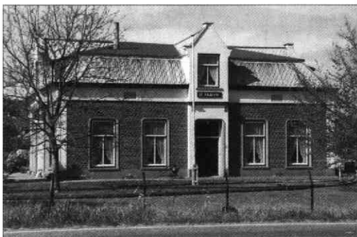
De in 1878 gebouwde boerderij De Raaphof, Schoudermantel 52. In 1897 werden hier enige maanden twee kamers gehuurd door de gemeente en gebruikt als secretarie tijdens het in aanbouw zijnde nieuwe gemeentehuis. (foto: Ank van Asperen Vervenne - van Zanten, Odijk, 1996)
