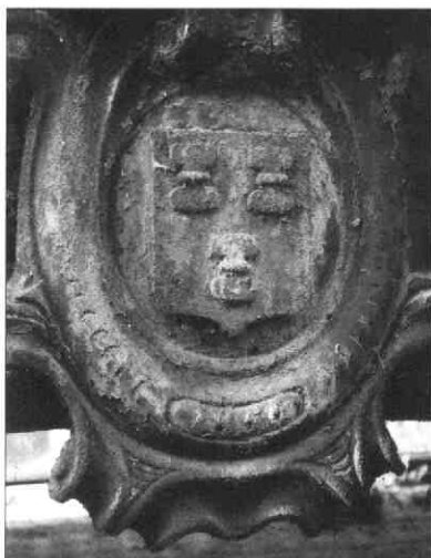
Detail smeedijzeren spanten met gietijzeren ornamenten van de grote brug
