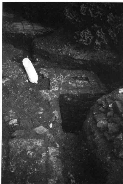
4. Overzichtsfoto van put 1-2 met het fundament van het gotische koor, gefotografeerd in oostelijke richting
