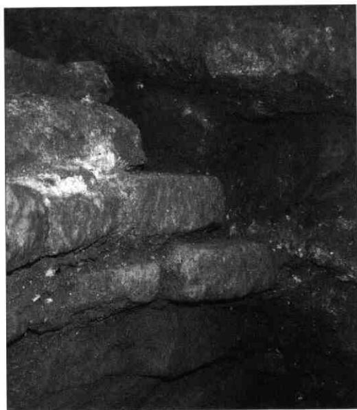
9. Ontmoeting van het fundament van de toren (rechts) met het fundament van de westgevel van de kerkzaal. De keifundering van de toren is minder diep aangezet dan de tufstenen fundering van de kerkzaal
