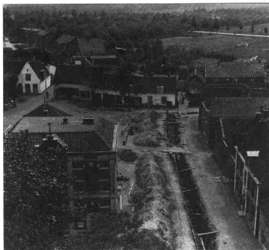
Gezicht vanaf de Nederlands Hervormde kerktoeren op het Plein met links het voormalige gemeentehuis. Rechts is te zien dat men bezig is met de aanleg van de riolering (foto uit 1956; Topografische verzameling van de gemeente Houten)
