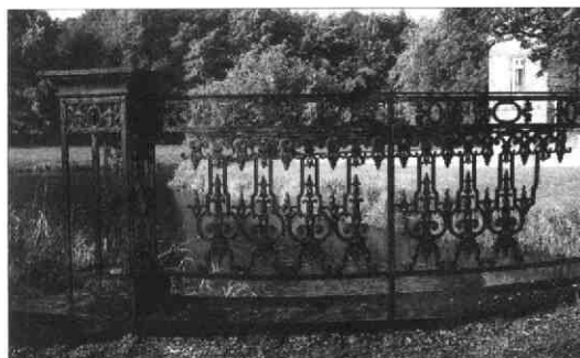
Brughek van de grote brug van Beverweerd voor de restauratie
