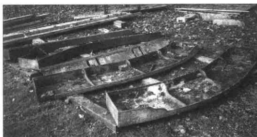
Gietijzeren holle afdekplaten afkomstig van de gemetselde landhoofden van de grote brug
