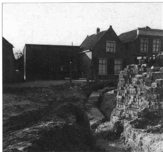
Een gedeelte van de gevonden kerkhofmuur ten zuiden van de kerk (foto uit 1956; Topografische verzameling van de gemeente Houten)
