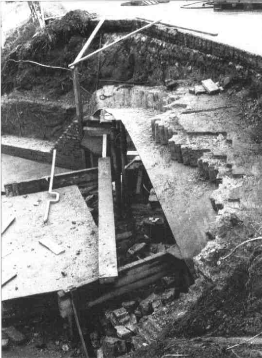
Links: de staande losgeraakte stenen van het gewelf zijn verwijderd. Rechts: vanaf de aanzetsteen wordt het gewelf weer opgemetseld met behulp van een formeel
