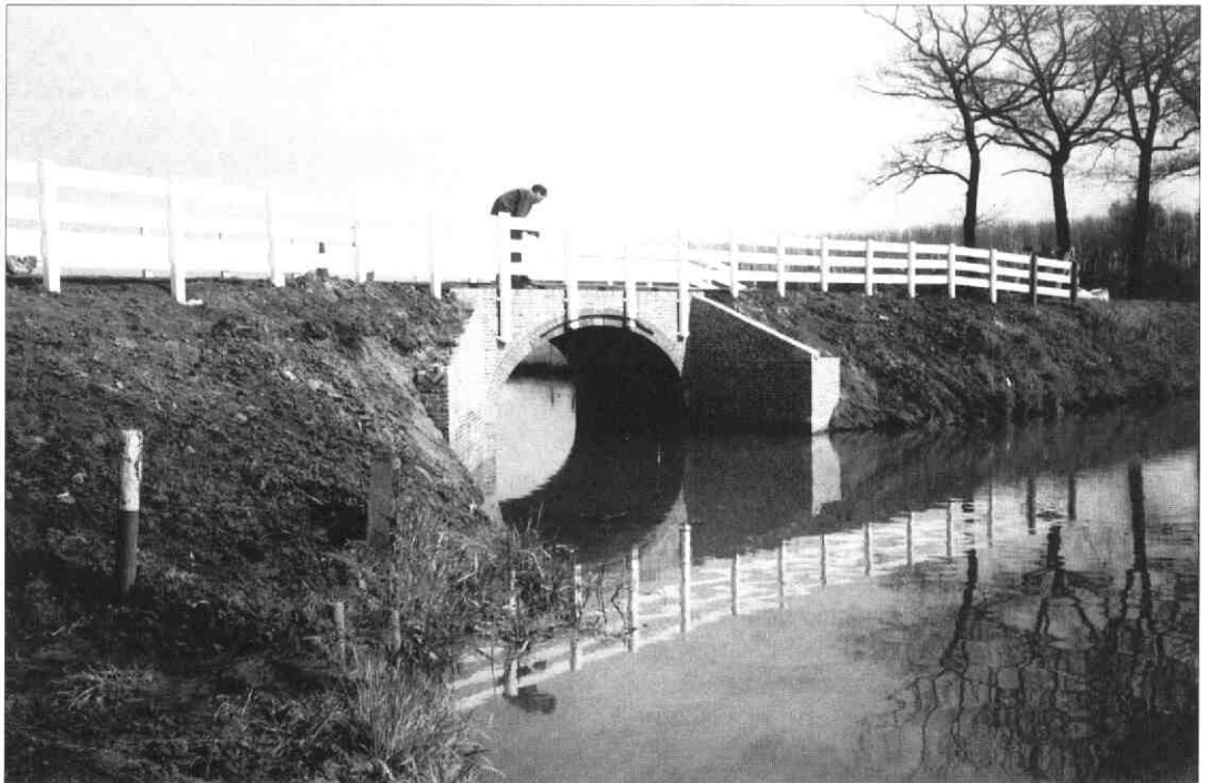
De brug na de restauratie
