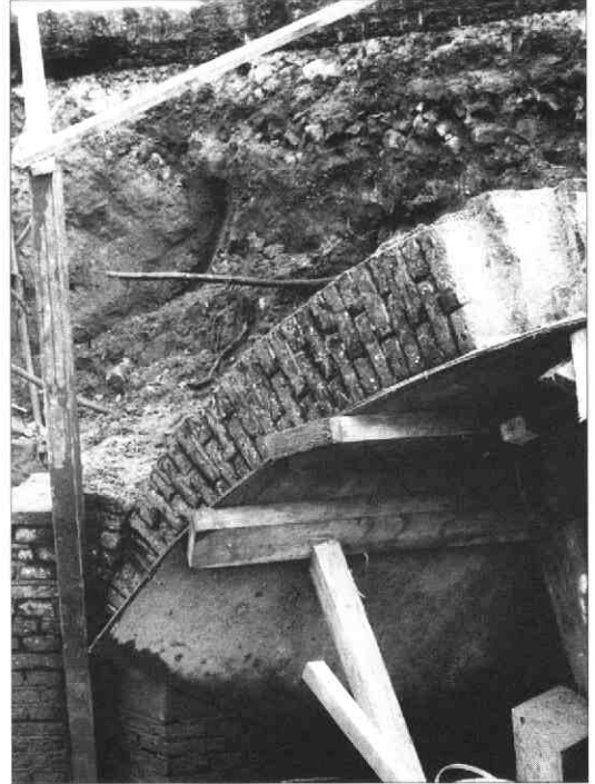
Links: de staande losgeraakte stenen van het gewelf zijn verwijderd. Rechts: vanaf de aanzetsteen wordt het gewelf weer opgemetseld met behulp van een formeel
