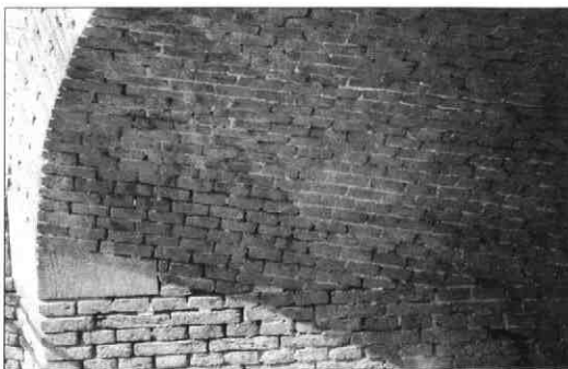
Het metselwerk met zijn wigvormige inzet
