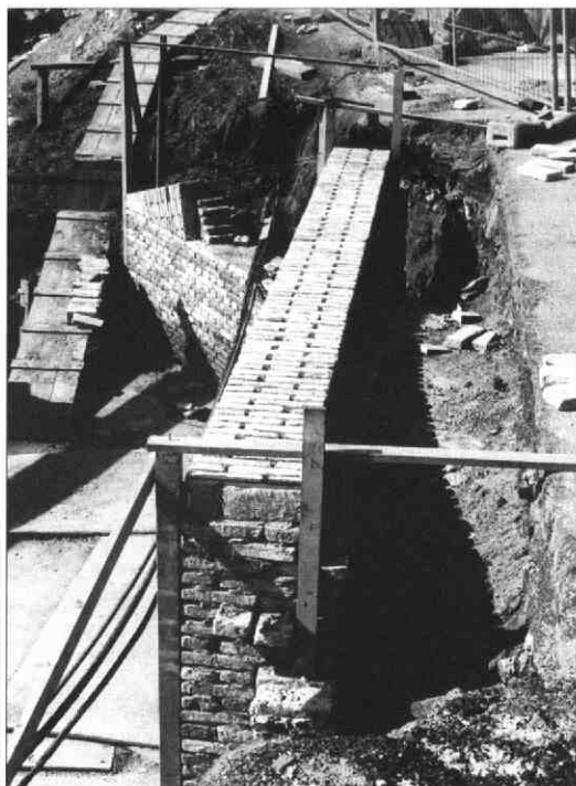
De frontmuur boven de doorgang is weer opgemetseld
