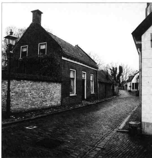
5. Het in 1852 nieuw gebouwde woonhuis (Hans Dirksen Fotografie, 2001)
