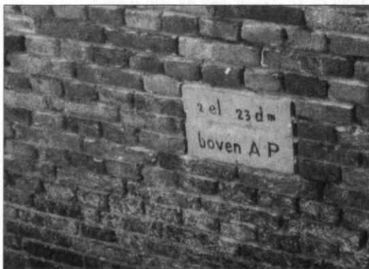
Het peilsteentje tijdens de restauratie van de brug in 1999 (foto auteur)
