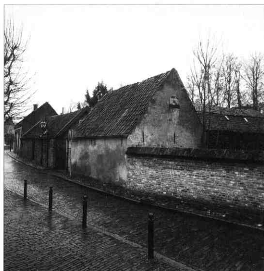
4. Het oude woonhuis en washuis vanaf de straatzijde en de tuinzijde gezien. Een pleisterlaag onttrekt het metselwerk van kloostermoppen grotendeels aan het gezicht (Hans Dirksen Fotografie, 2001)
