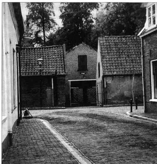
8. Het wasserijcomplex gezien vanuit de Volderstraat, met links van het toegangshek de nog altijd zichtbare plaats van de pomp (foto auteur, 2000)
