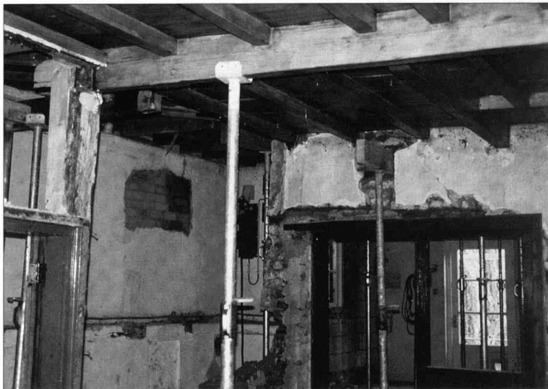
6. Interieur met grotendeels gesloopte binnenmuren met links de kelder en achteraan de brandmuur met deur naar het voormalige achterhuis (Foto auteur, september 2001)
