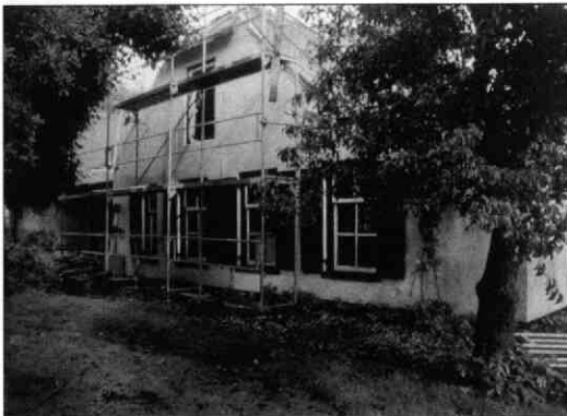
4. De voorgevel tijdens de verbouwing (Foto auteur, september 2001)
