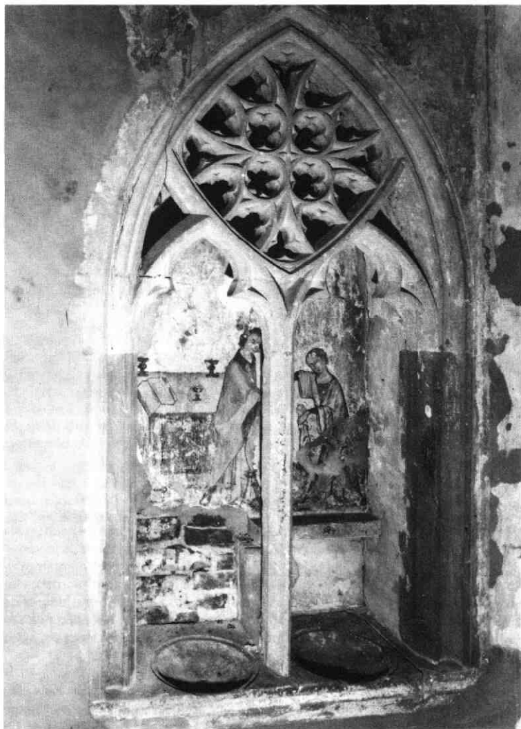
2. De piscina in het voormalige huis de Rode Poort, Domplein 4-5. Foto: Gemeentelijke Fotodienst, 1989 (neg.nr. K 1.711 A).
