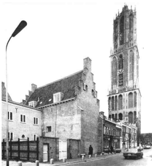
De achtergevel van Wed 7 met de tufstenen resten die dateren uit de bouwtijd in het begin van de dertiende eeuw.
