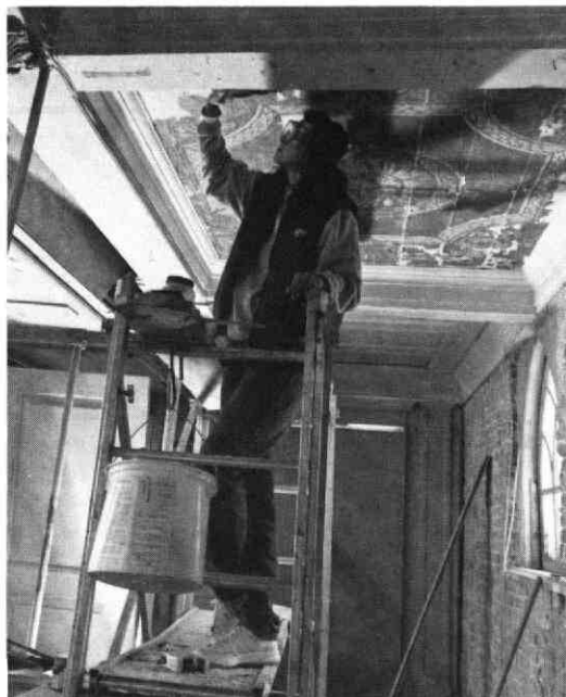
Aan 't werk: Marianne Deelen, één van de restaurateurs bij het schoonmaken van de plafonds boven de galerijen. Gemeentelijke Fotodienst Utrecht, negatiefnr. B 10353-B.
