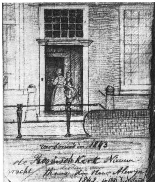
De eerste Jezuïetenstatie (Catharijnesteeg). Gezicht op de voorgevel der kerk aan de Nieuwegracht vóór de verbouwing van 1843, Gemeentelijke Archiefdienst Utrecht, Topografische Atlas Kb. 3. 1. (foto: Gemeentelijke Archiefdienst, Utrecht).
