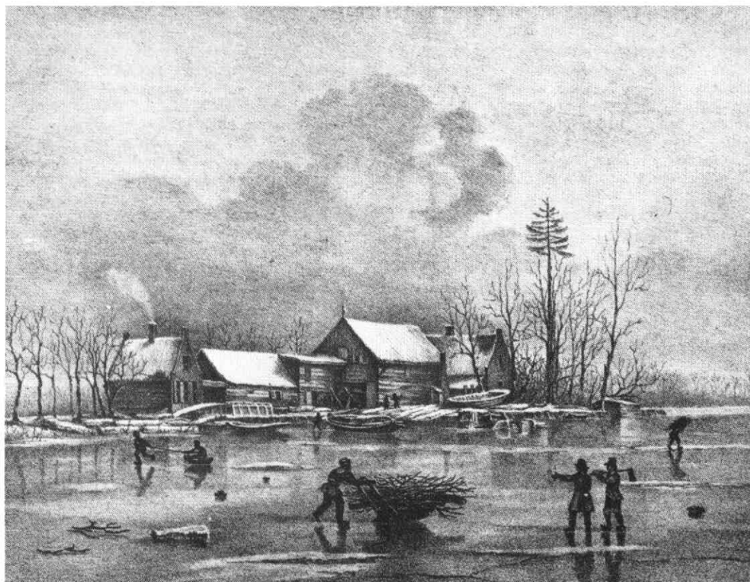
Afb. 4. Wintergezicht op de sloopstimmerwerf tegenover het buiten Nieuwerhoek bij Loenen (P. J. Lutgers, 1836).
