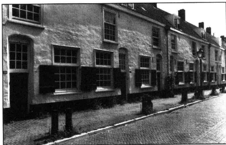
Springweg 110 tot en met 130. De Mieropscameren aan de Springweg behoren tot de vroegste aankopen van het Utrechts Monumentenfonds (1968). Foto: Hans Collard Utrechts Monumentenfonds vijftig jaar
