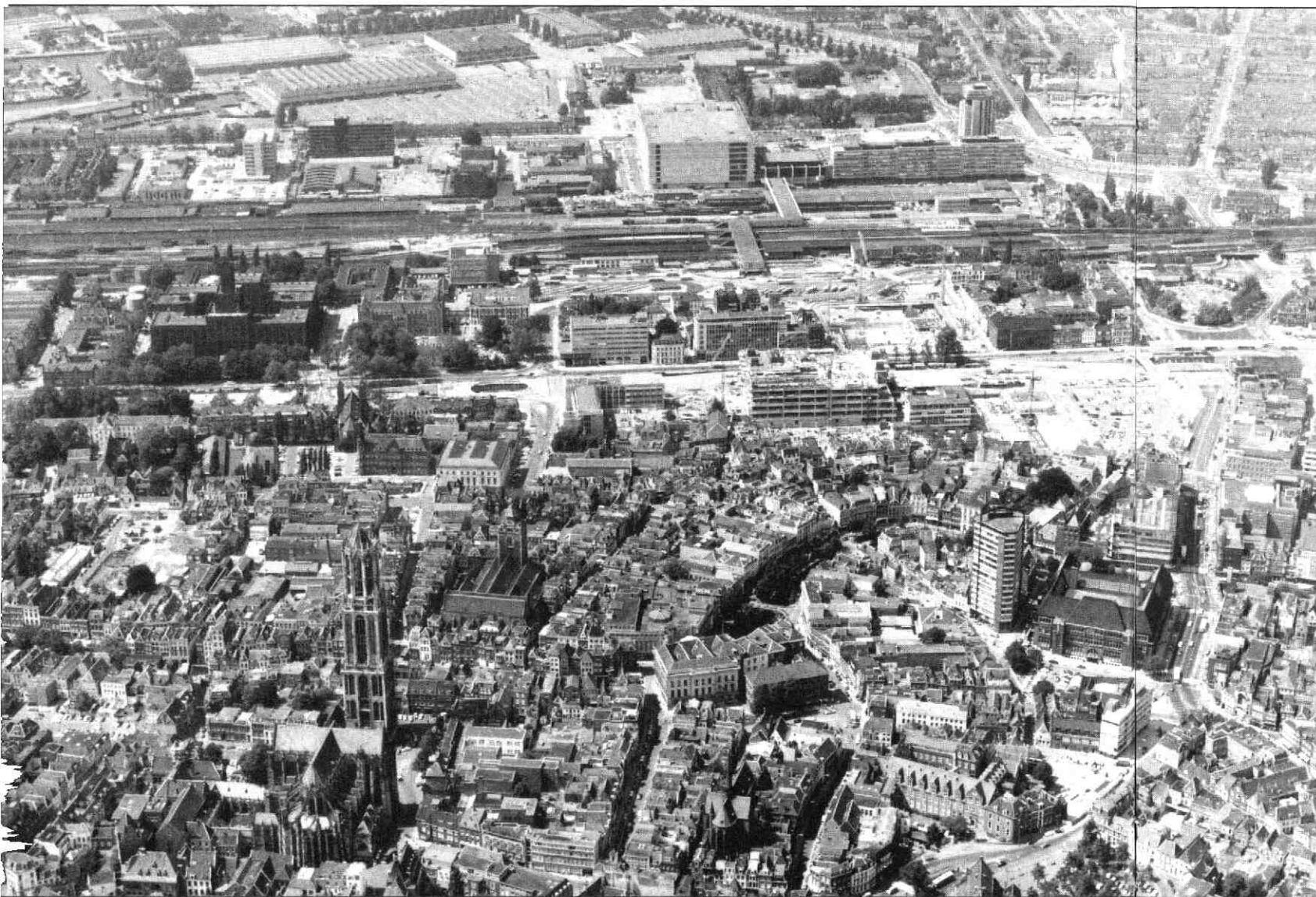
6 Hoog Catharijne in aanbouw
