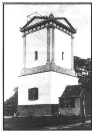
Achterzijde van de toren, met daaraan vastgebouwd het doodgravershuisje dat in 1950 werd afgebroken
