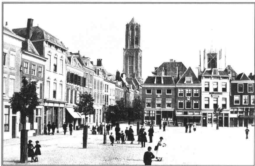
1. De Neude aan het einde van de 19de eeuw. Rechts op de foto (Neude 37) het bureau van de Nederlandsche Bell Telefoon Maatschappij, met op het dak de merkwaardige kooiconstructie. Foto: Gemeente-archief, Utrecht.
