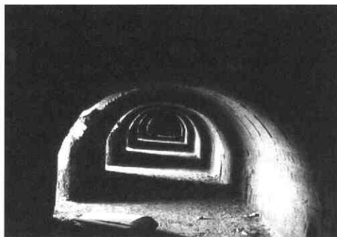
Blik in de ovenschaft van steenfabriek de Bosscherwaarden
