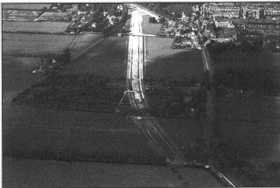
Deze luchtfoto uit 1937 toont de aanleg van de gemoderniseerde Rijksweg 25 buiten de bebouwde kom van De Bilt om. De veertig meter brede weg was aanzienlijk breder dan de oorspronkelijke verbinding. Linksboven zien we nog net de weertoren van het KNMI, rechtsboven de dorpskern van De Bilt. Foto: Het Utrechts Archief
