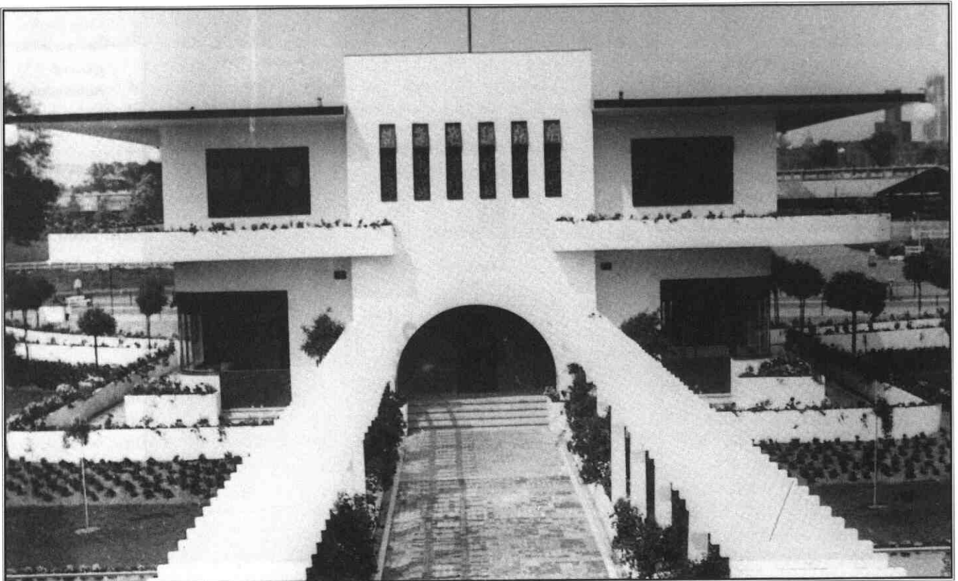
Zicht op de achtergevel van de villa vanuit de hal. Achter de smalle glas-in-lood ramen bevindt zich de huiskapel.
