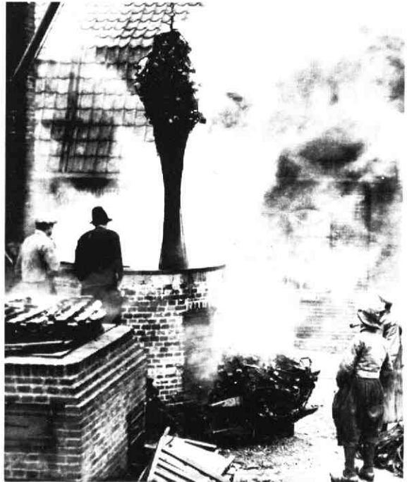
Het teren of tanen van visnetten voor het tegengaan van vochtinwerking.
