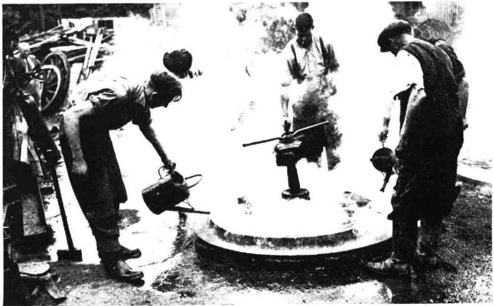
Het krimpen van de ijzeren hoepel om het wiel.
